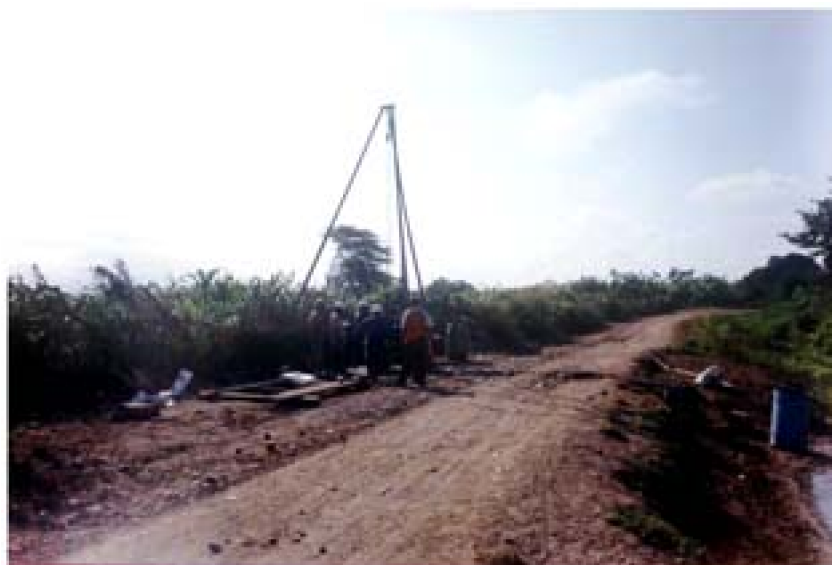
7.- Vista de la perforación en el lado peruano (P - 1).
