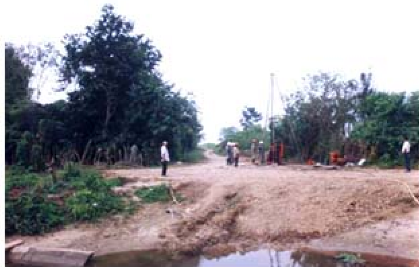
9.- Vista de la vía paralela al Canal Internacional Aguas Verdes.
