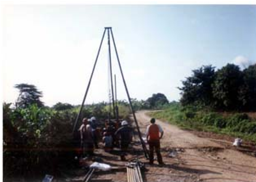
10.- Vista hacia el territorio Ecuatoriano, eje del puente proyectado
