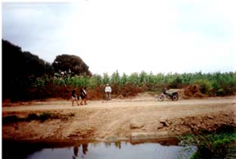
5.- Vista de la vía paralela al Canal Internacional Aguas Verdes.
