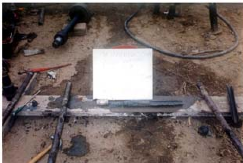
13.- Vista de las muestras extraídas del estribo izquierdo del Canal Internacional Aguas Verdes (P - 1), recuperadas en el tubo muestreador del (SPT). Es posible apreciar las muestras de suelos de naturaleza limoarcillosa, definida en laboratorio como (CL, ML y CH ) respectivamente.
