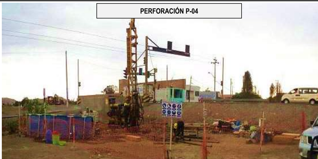
PERFORACIÓN P-04: INSTALACIÓN DE EQUIPO CONO PECK PARA REALIZAR ENSAYO
