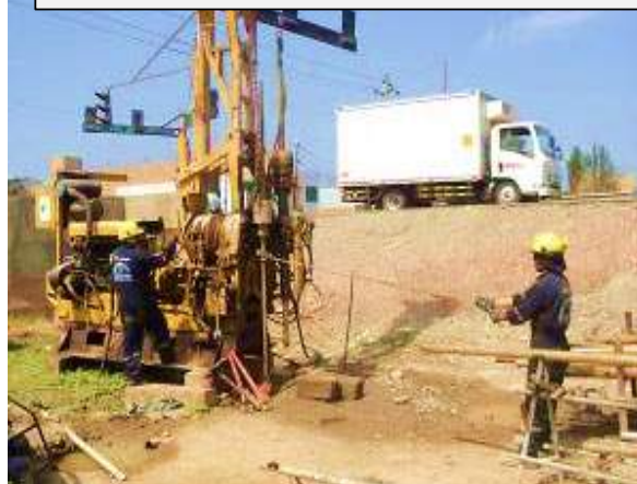
PERFORACIÓN P-04: INSTALACIÓN DE TUBERÍA PVC - MEDICIÓN DE NIVEL FREÁTICO
