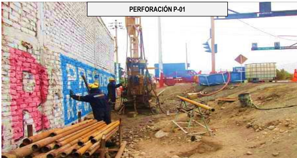
PERFORACIÓN P-01: INSTALACIÓN DE EQUIPO CONO PECK PARA REALIZAR ENSAYO
