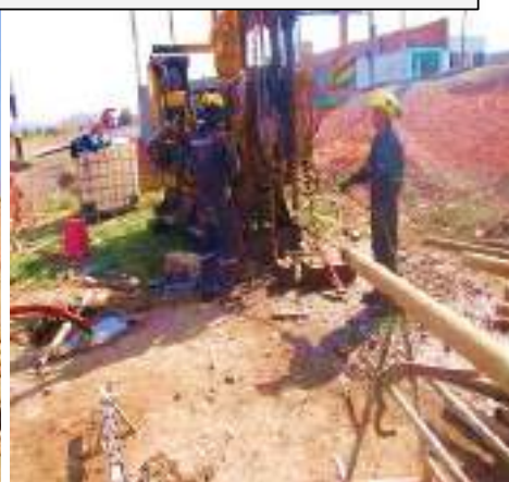
PERFORACIÓN P-04: INSTALACIÓN DE TUBERÍA PVC - MEDICIÓN DE NIVEL FREÁTICO
