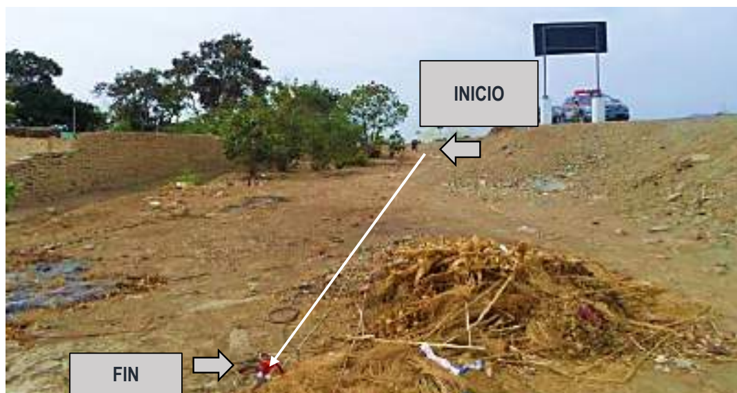
Fotografía 09: Cables extendidos y listos para realizar Ensayo de Refracción sísmica.
