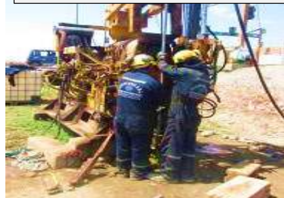
PERFORACIÓN P-04: INSTALACIÓN DE TUBERÍA PVC - MEDICIÓN DE NIVEL FREÁTICO
