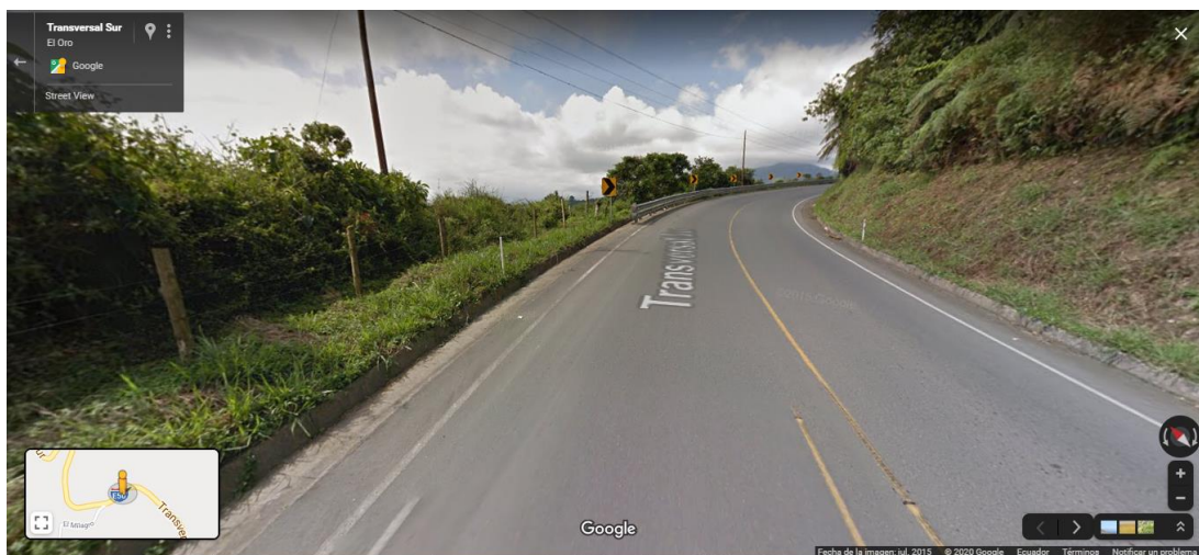
Anexo 4. Diferentes carreteras tipo regional (De arriba hacia abajo, tramos: Machala - Piñas; El Guabo - Pasaje; Santa Rosa - Balsas)
