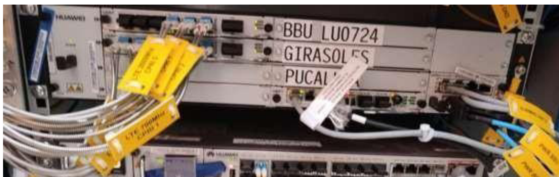
Figura 19. Conexión de la BBU
