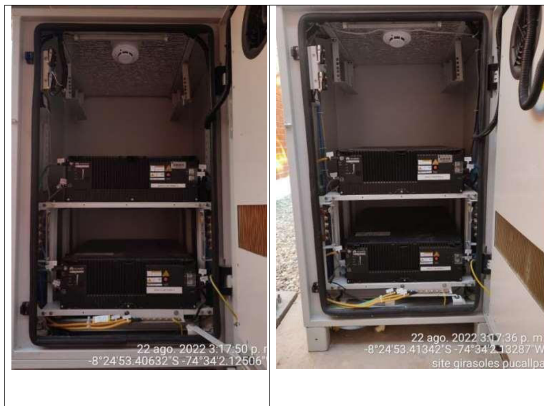
Figura 23. Instalación de baterías en gabinete 1 y 2.
