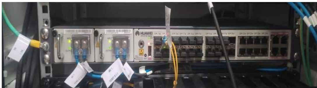
Figura 20. Energizado y aterramiento del router
