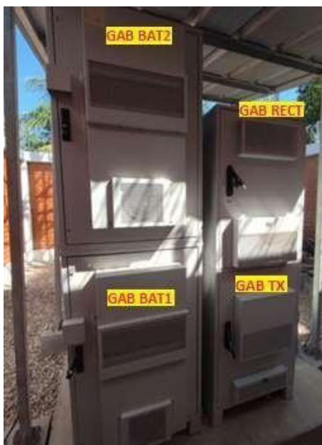
Figura 17. Anclado de gabinetes en losa de equipos
