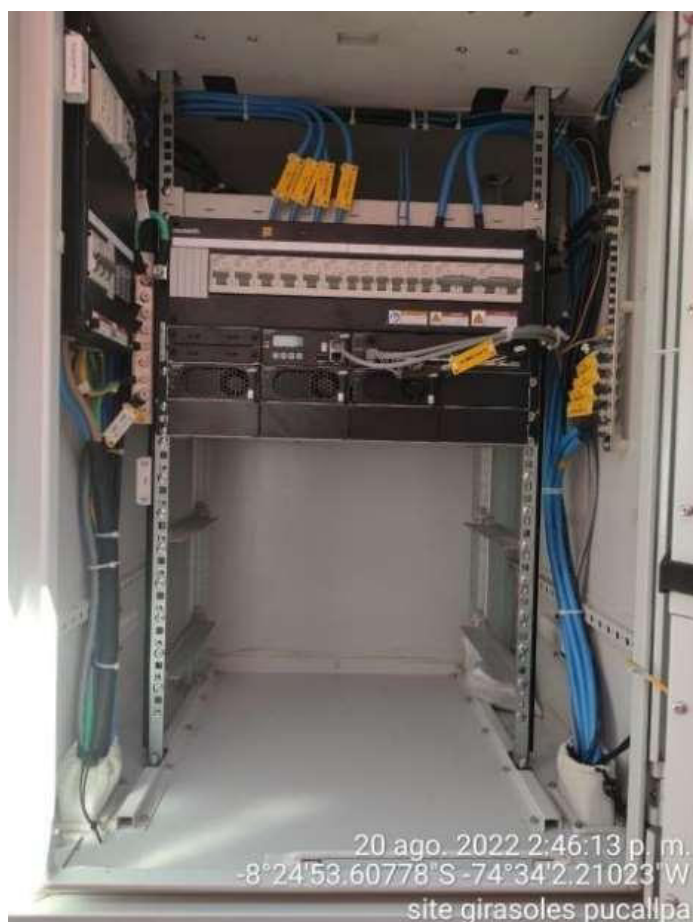
Figura 21. Equipos en gabinete rectificador
