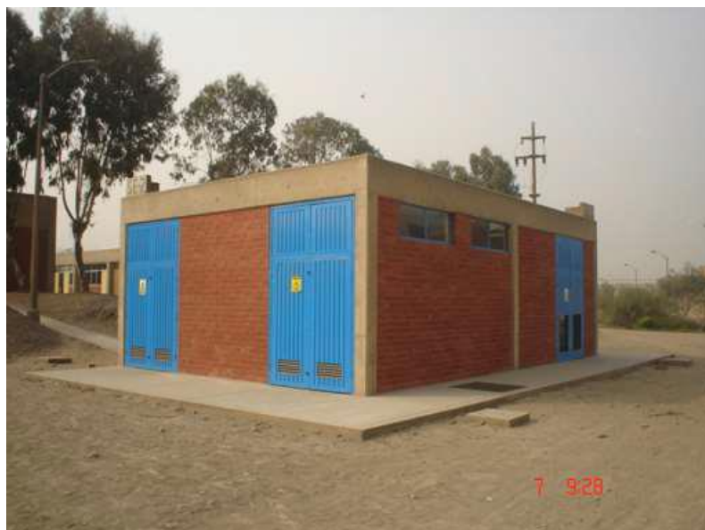
Figura 8. Subestación en caseta. Fuente: Equipamiento de subestaciones de distribución, (Ascencio Yoel, 2019)
