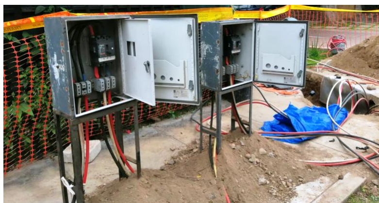
Figura 137. Instalación de llaves puentes (LP-1 y LP-2) para el traslado de carga. Fuente. Autoría propia.
