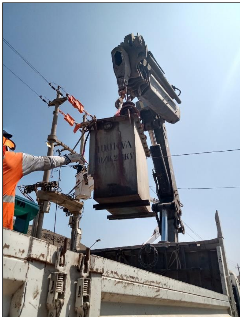
Figura 129. Colocando el transformador en el camión para su traslado. Fuente. Autoría propia.
