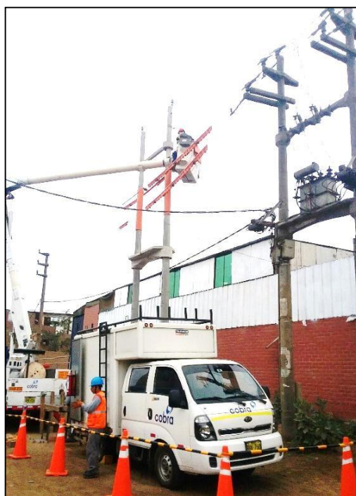
Figura 111. Aislando las líneas energizadas. Fuente. Autoría propia.
