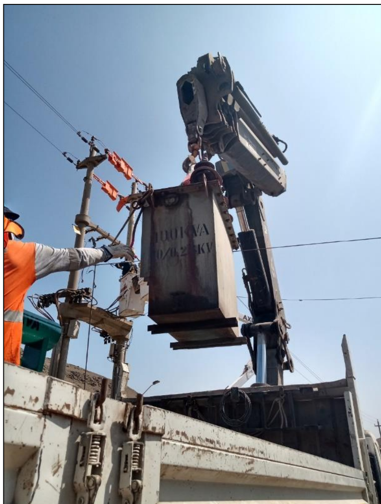
Figura 86. Colocando el transformador en el camión para su traslado. Fuente. Autoría propia.
