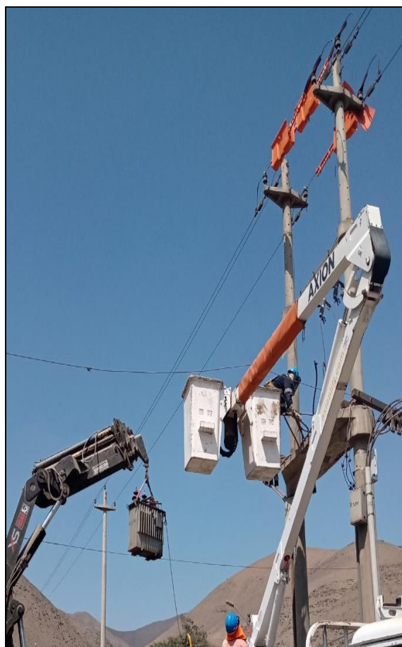
Figura 128. Retiro de Transformador antiguo de SED 04805A. Fuente. Autoría propia.
