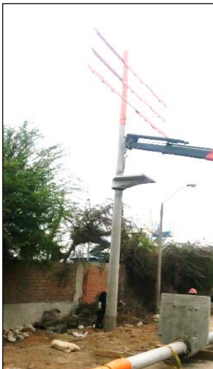
Figura 67. Izamiento de poste con la grúa. Fuente. Autoría propia.
