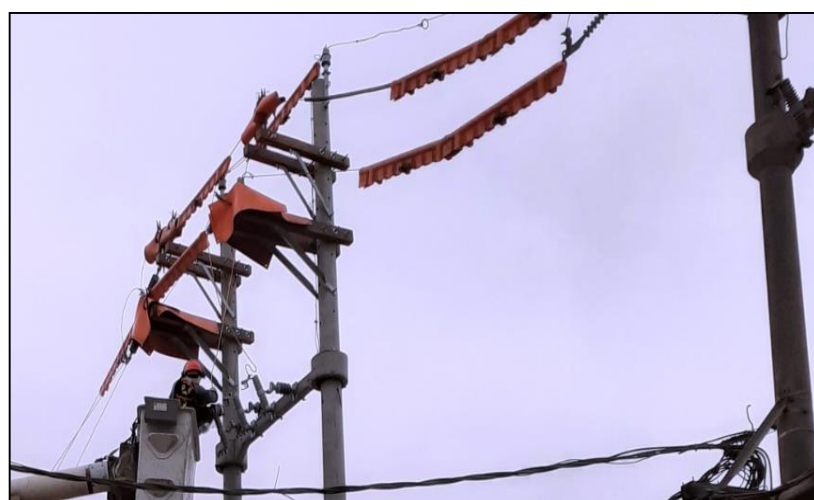
Figura 76. Instalación de Sistema de Puesta a Tierra. Fuente. Autoría propia.
