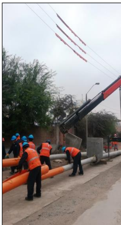
Figura 66. Preparación de los postes de MT. Fuente. Autoría propia.
