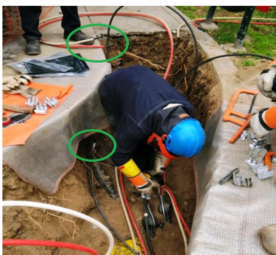
Figura 139. Realizando los empalmes de cable para llaves puente. Fuente. Autoría propia.
