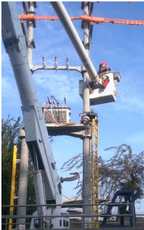
Figura 79. Instalación del cable de comunicación. Fuente. Autoría propia.
