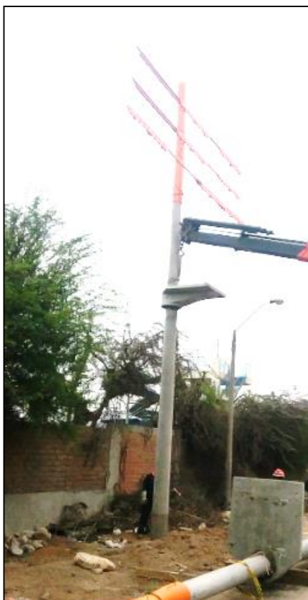
Figura 110. Izamiento de poste con la grúa. Fuente. Autoría propia.
