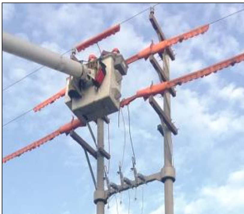
Figura 124. Conexión de Cable de comunicación desde los Cut-Out's hacia la barra MT, fase por fase. Fuente. Autoría propia.
