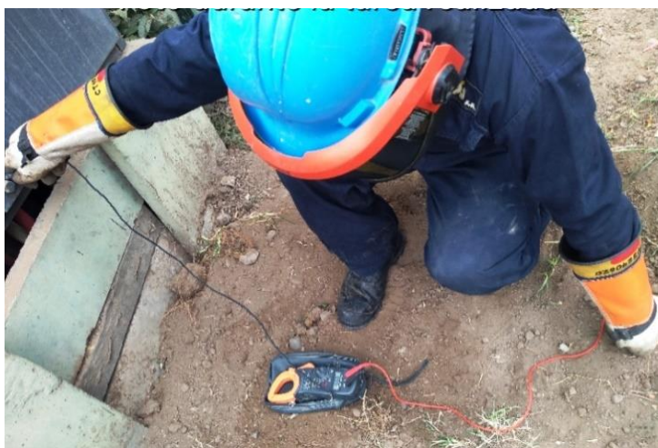
Figura 131. Medición de ausencia de tensión de electrizamiento. Fuente. Autoría propia.
