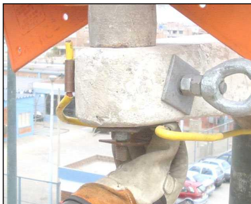
Figura 77. Instalación de sistema de puesta a Tierra en ménsulas. Fuente. Autoría propia.
