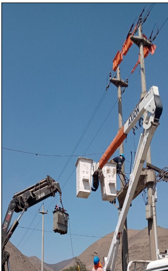
Figura 85. Retiro de Transformador antiguo de SED 04805A. Fuente. Autoría propia.
