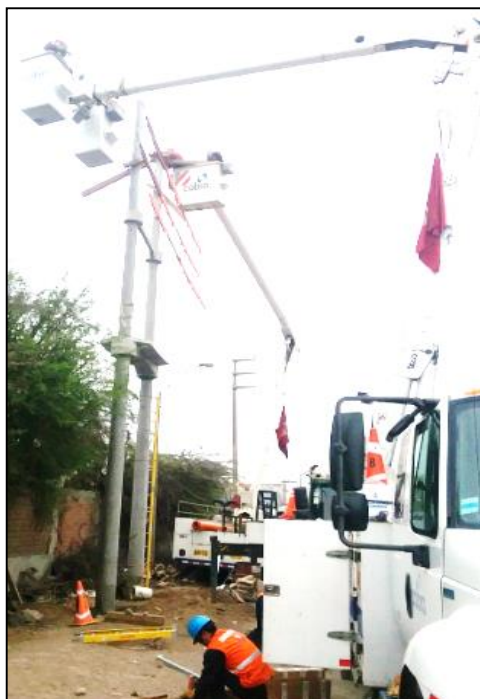
Figura 69. Operación de dos grúas para el aislamiento de las líneas. Fuente. Autoría propia.
