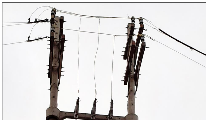
Figura 125. Conexión de Cable de comunicación desde Cut-Out-s hacia barra MT terminada. Fuente. Autoría propia.
