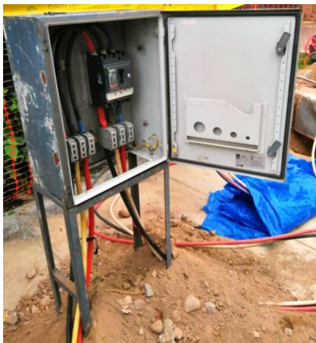
Figura 141. Poniendo en operación la llave puente 2. Fuente. Autoría propia.
