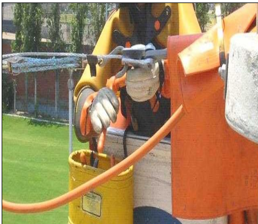
Figura 114. Instalación y sujeción del conductor en la grapa. Fuente. Autoría propia.
