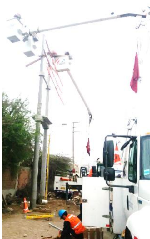
Figura 112. Operación de dos grúas para el aislamiento de las líneas. Fuente. Autoría propia.
