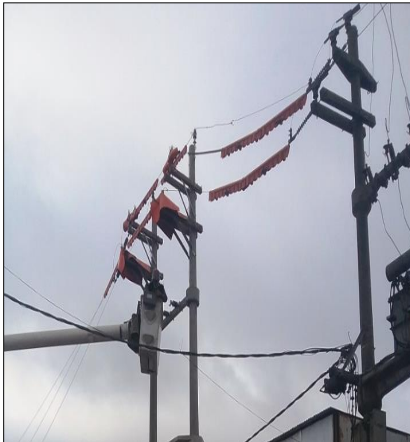
Figura 75. Instalación de seccionadores Cut-Out's. Fuente. Autoría propia.
