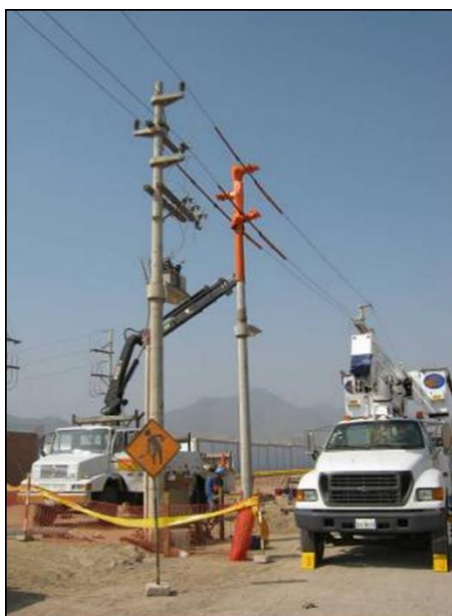
Figura 49. Renovación de SED aérea, caso típico 1. Fuente. Autoría propia.
