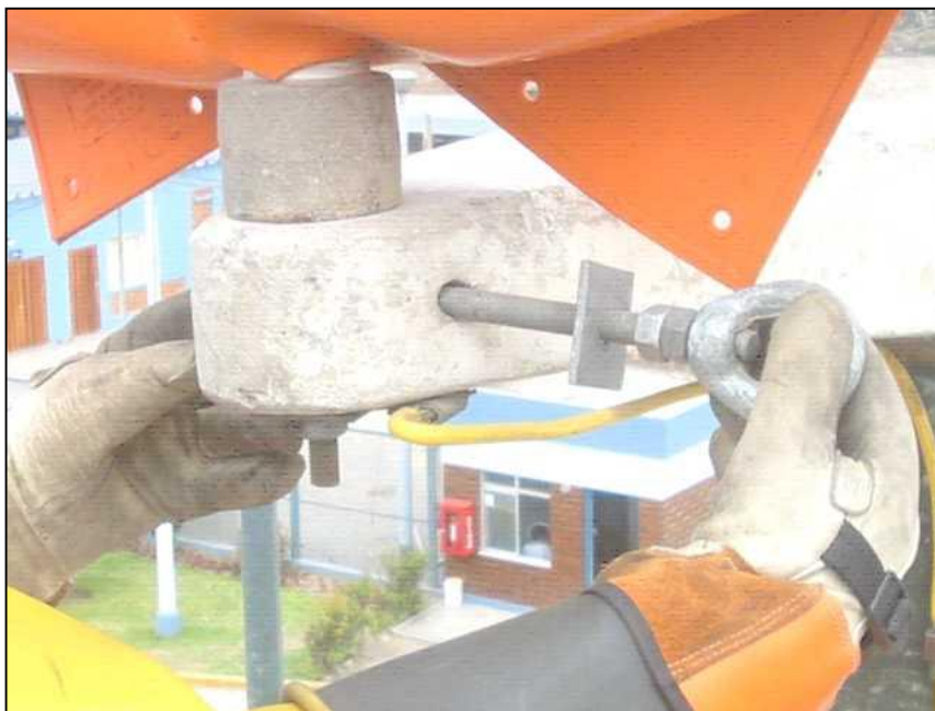
Figura 73. Instalación de varillas. Fuente. Autoría propia.
