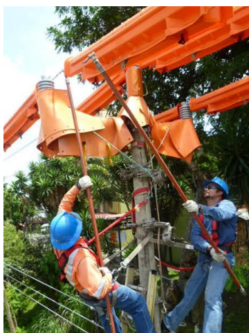
Figura 37. Aplicación en mantenimiento del método de trabajo a distancia.
