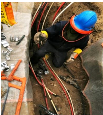
Figura 143. Empalme definitivo del cable proyectado. Fuente. Autoría propia.
