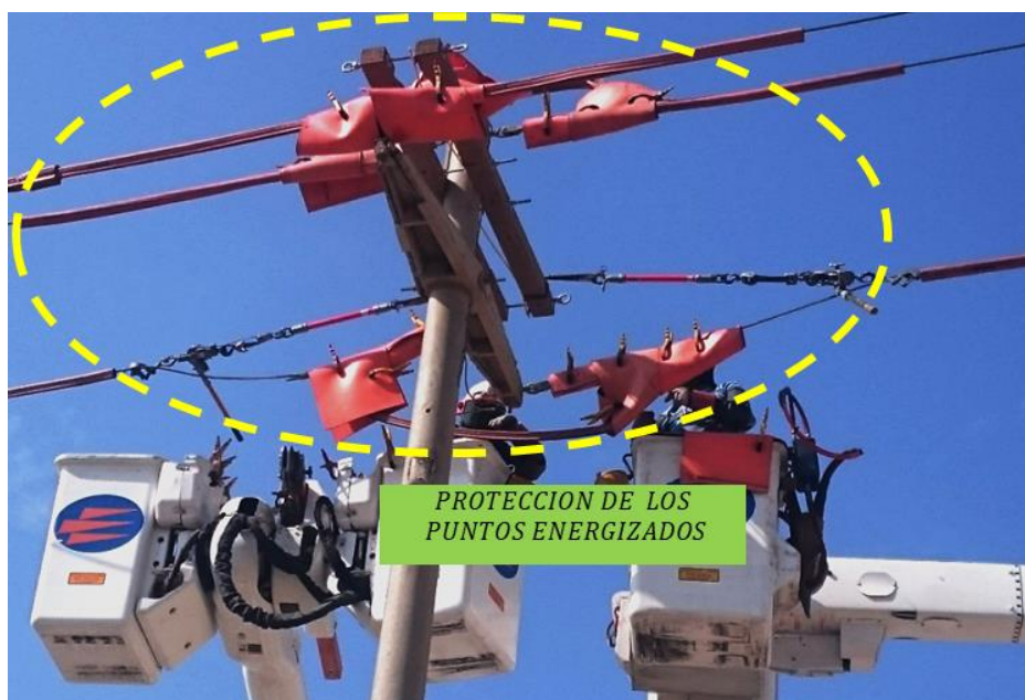
Figura 34. Método de trabajo a contacto, con líneas energizadas. Fuente. Autoría propia.
