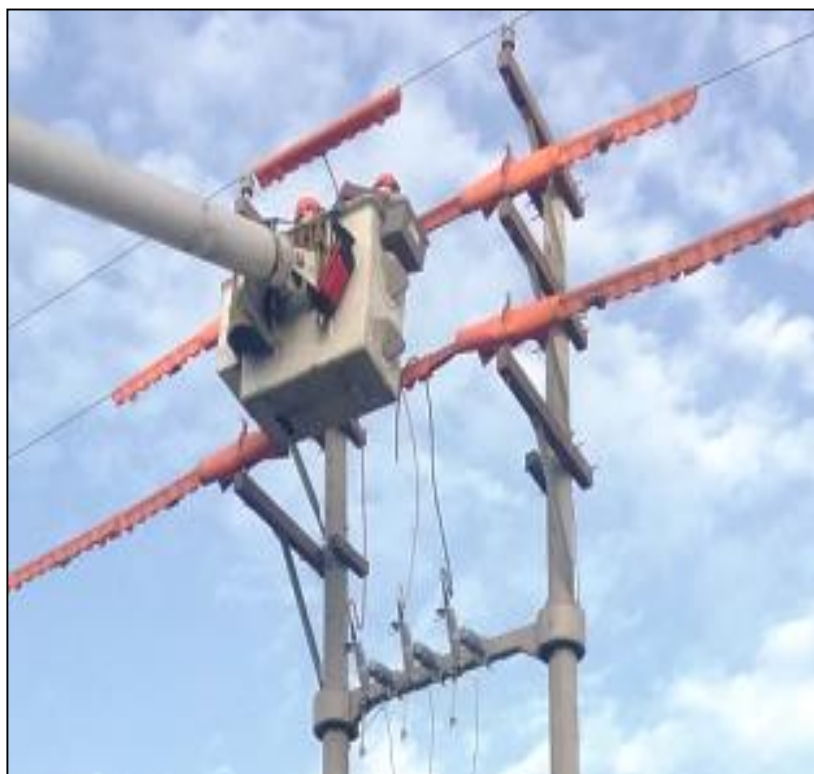
Figura 81. Conexión de Cable de comunicación desde los Cut-Out's hacia la barra MT, fase por fase. Fuente. Autoría propia.
