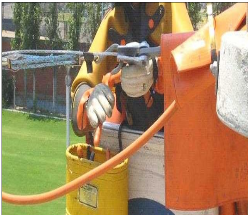
Figura 71. Instalación y sujeción del conductor en la grapa. Fuente. Autoría propia.
