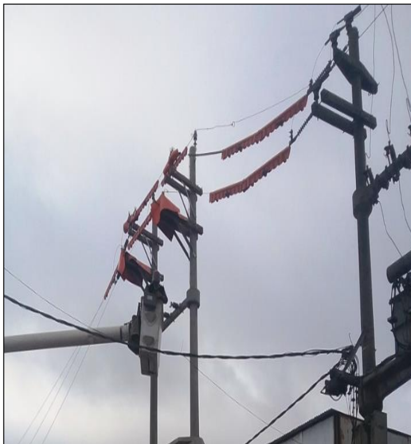
Figura 118. Instalación de seccionadores Cut-Out's. Fuente. Autoría propia.
