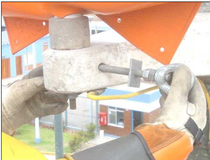
Figura 116. Instalación de varillas. Fuente. Autoría propia.
