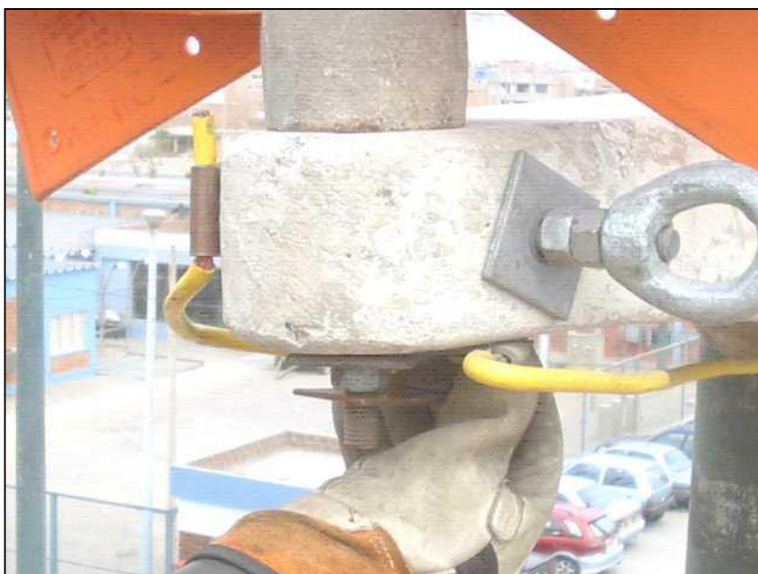
Figura 74. Instalación de planchas de cobre tipo J. Fuente. Autoría propia.
