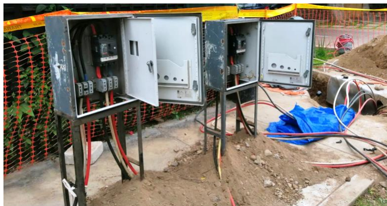
Figura 94. Instalación de llaves puentes (LP-1 y LP-2) para el traslado de carga. Fuente. Autoría propia.
