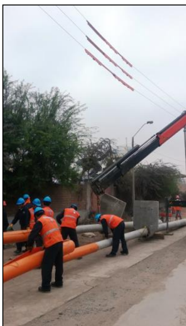
Figura 109. Preparación de los postes de MT. Fuente. Autoría propia.
