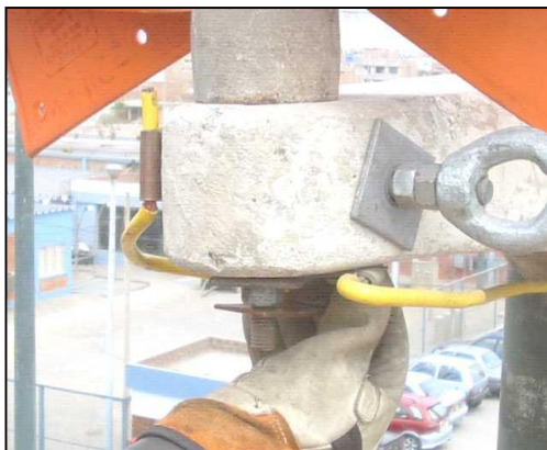
Figura 120. Instalación de sistema de puesta a Tierra en ménsulas. Fuente. Autoría propia.
