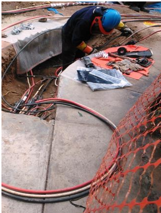
Figura 132. Verificación de los circuitos a intervenir. Fuente. Autoría propia.
