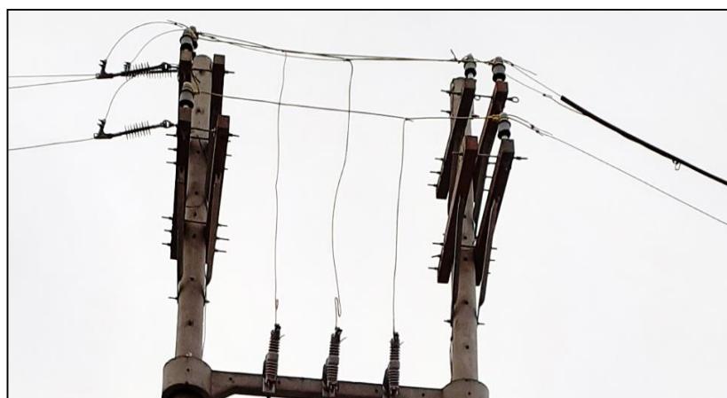
Figura 82. Conexión de Cable de comunicación desde Cut-Out-s. hacia barra MT terminada. Fuente. Autoría propia.
