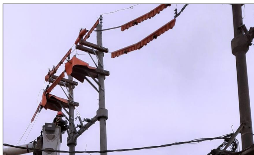
Figura 119. Instalación de Sistema de Puesta a Tierra. Fuente. Autoría propia.
