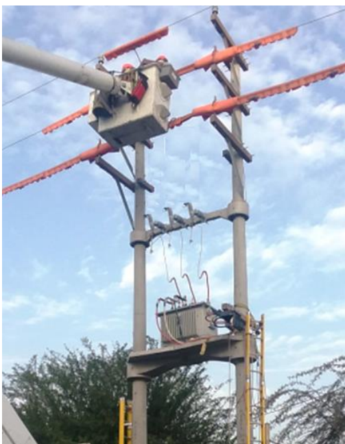
Figura 80. Instalación de barra de trapecio. Fuente. Autoría propia.
