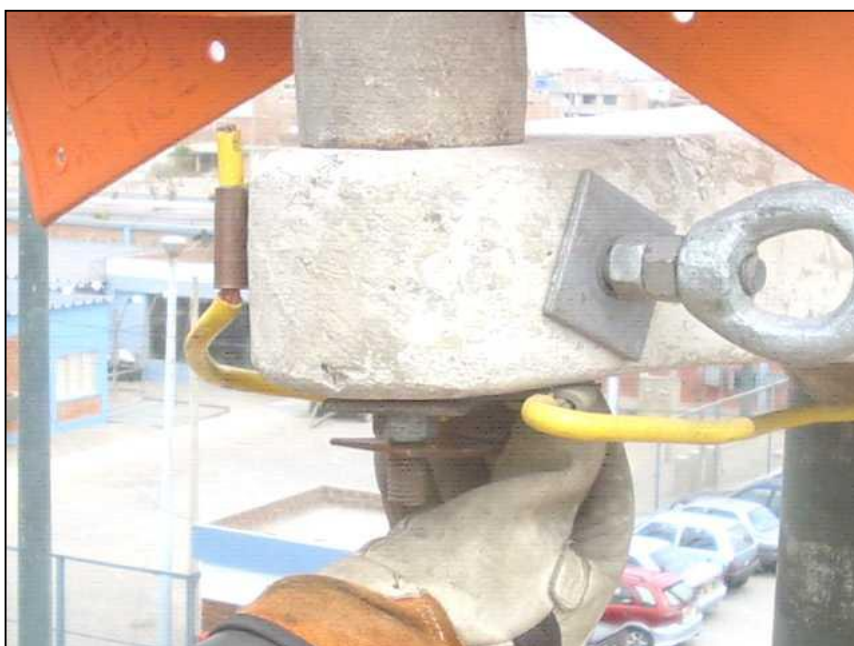
Figura 117. Instalación de planchas de cobre tipo J. Fuente. Autoría propia.
