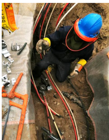
Figura 100. Empalme definitivo del cable proyectado. Fuente. Autoría propia.
