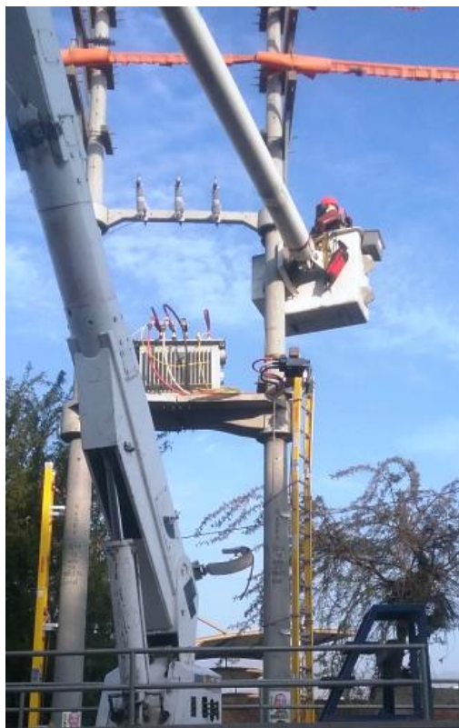
Figura 122. Instalación del cable de comunicación. Fuente. Autoría propia.
