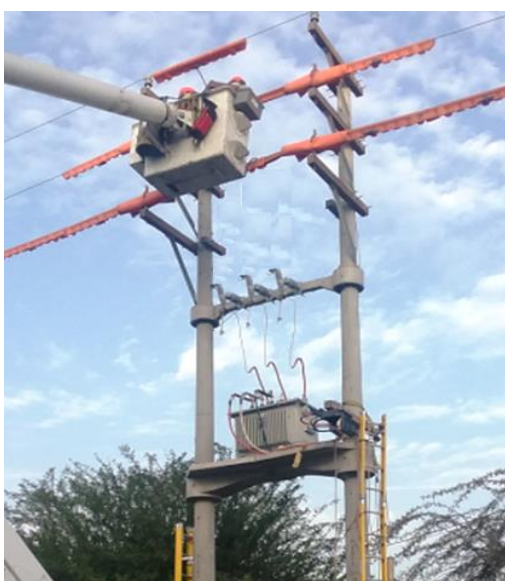
Figura 123. Instalación de barra de trapecio. Fuente. Autoría propia.
