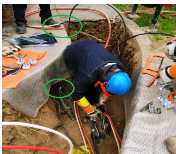
Figura 96. Realizando los empalmes de cable para llaves puente. Fuente. Autoría propia.
