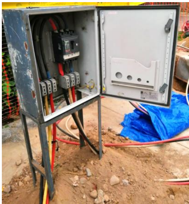
Figura 98. Poniendo en operación la llave puente 2. Fuente. Autoría propia.
