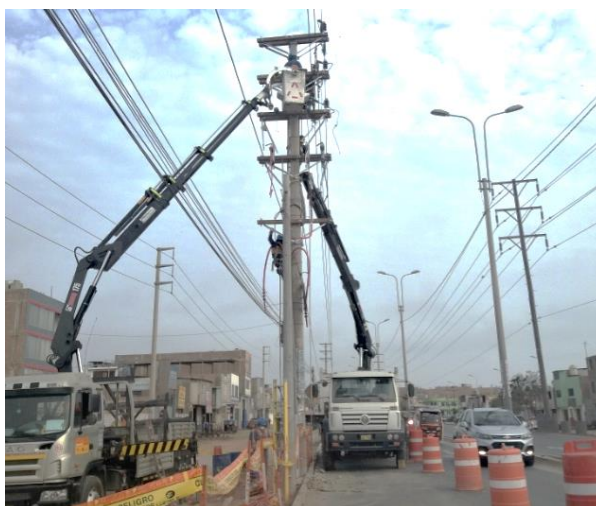
Figura 23. Ejemplo de trabajos con corte de energía eléctrica. Fuente: Autoría propia.
