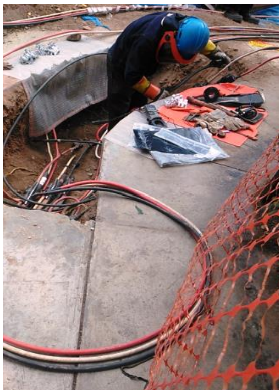
Figura 89. Verificación de los circuitos a intervenir. Fuente. Autoría propia.
