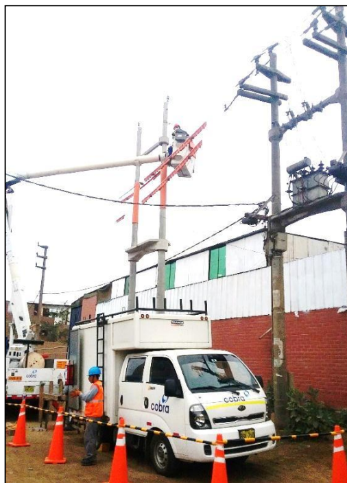
Figura 68. Aislando las líneas energizadas. Fuente. Autoría propia.
