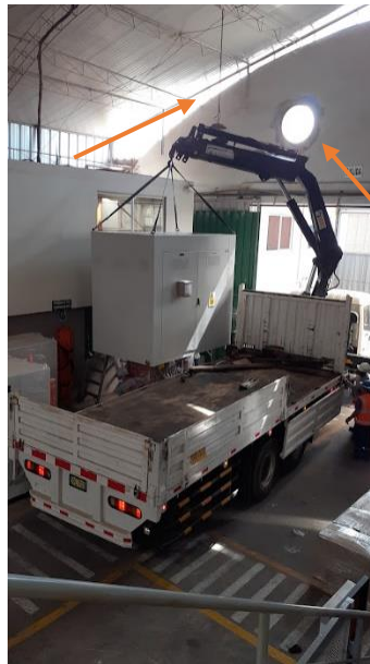
Figura A-11: Ventilación del área de trabajo.
