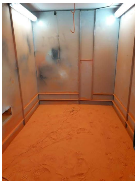
Figura A-12: Zona de contención de polvo (esclusa de pintado).
