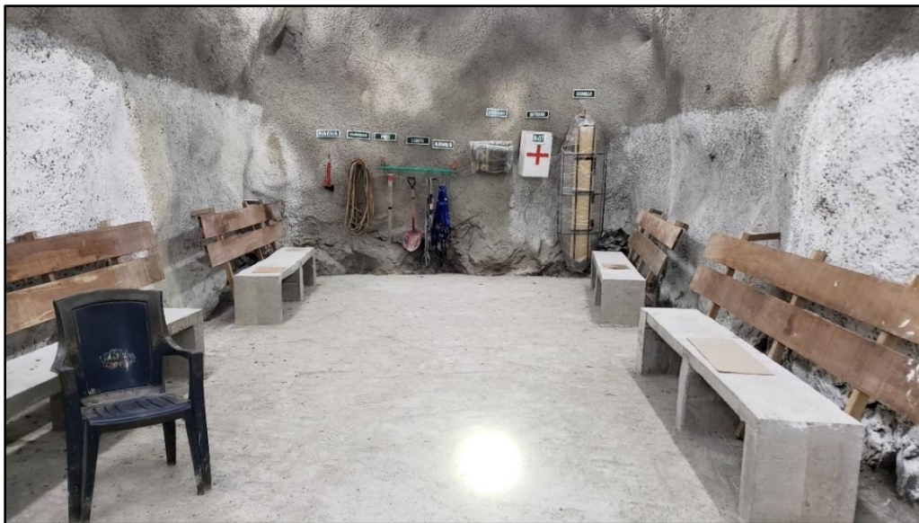
Figura 62: Cámara de recuperación con acondicionamiento de aire – Interior.
