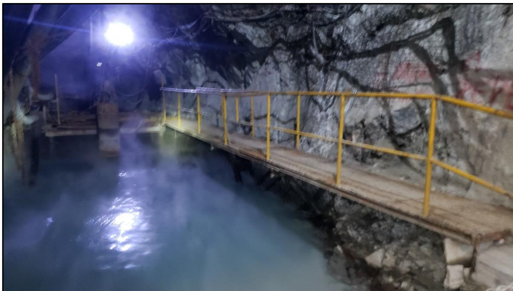
Figura 35: Estación de acumulación de agua (bombeo).
