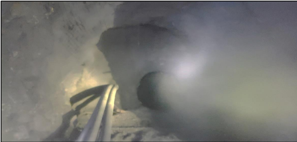
Figura 41: Infraestructura civil antigua que regula el flujo de aire – RB_2.
