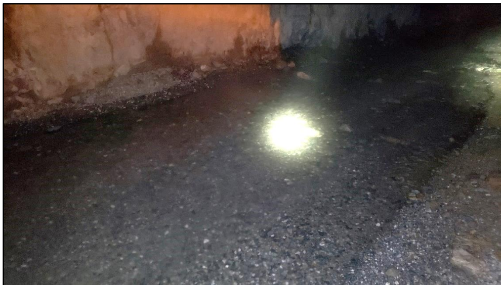
Figura 32: Referencia de volumen de filtración de agua termal.
