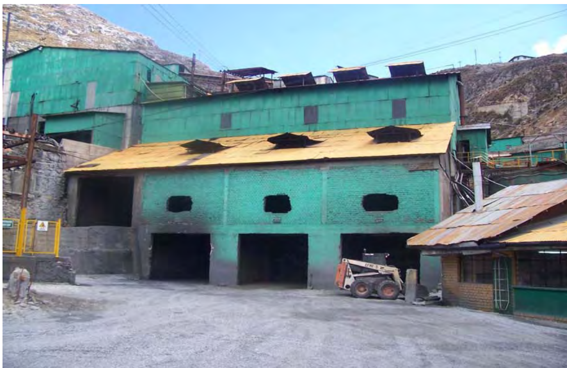
Foto 5-4: AREA DE DESPACHO DE CONCENTRADOS
