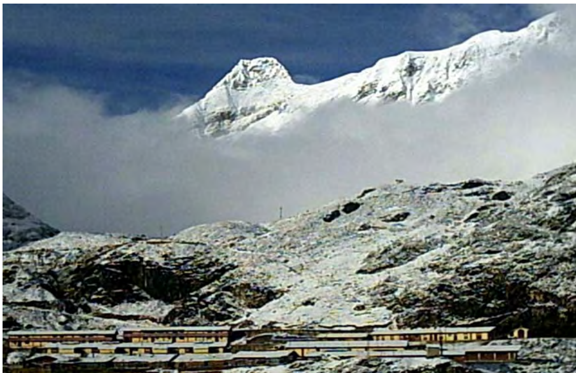
Foto 6-1: VISTA PANORAMICA DEL CAMPAMENTO DE CIA. MINERA RAURA S.A.
