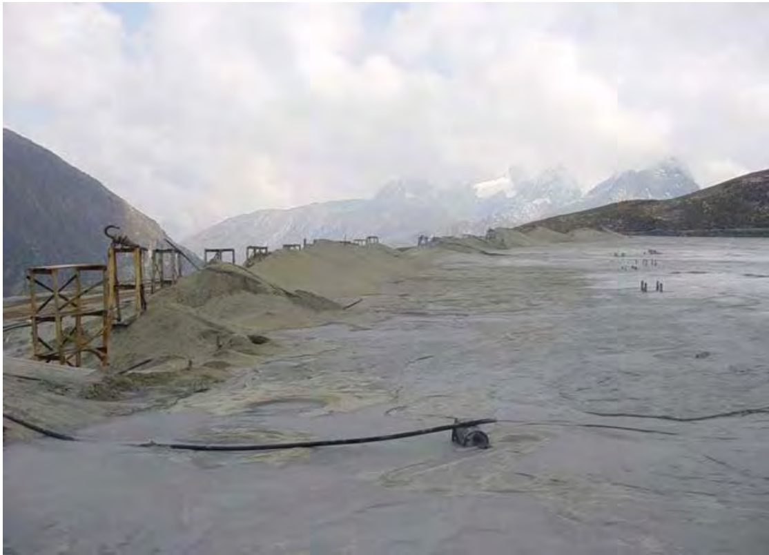
Foto 7-3: RELAVERA DE NIEVE UCRO II, SE APRECIA LOS CICLONES PARA CLASIFICAR LOS GRUESOS A LOS CONOS Y FINOS AGUAS ARRIBA
