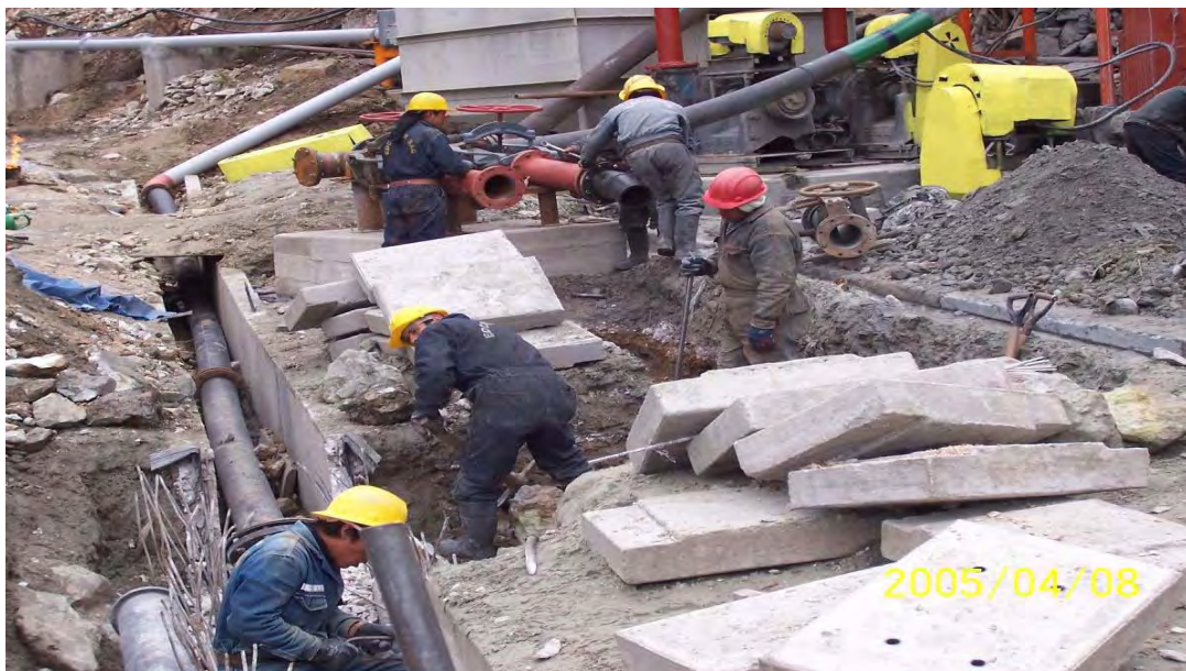
Foto 7-7: TENDIDO DE LA LINEA DE RELAVES, DISPOSICION SUBACUATICA
