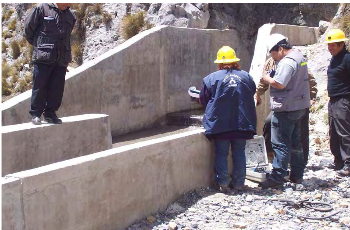
Foto 7-10: MONITOREO DE EFLUENTES
