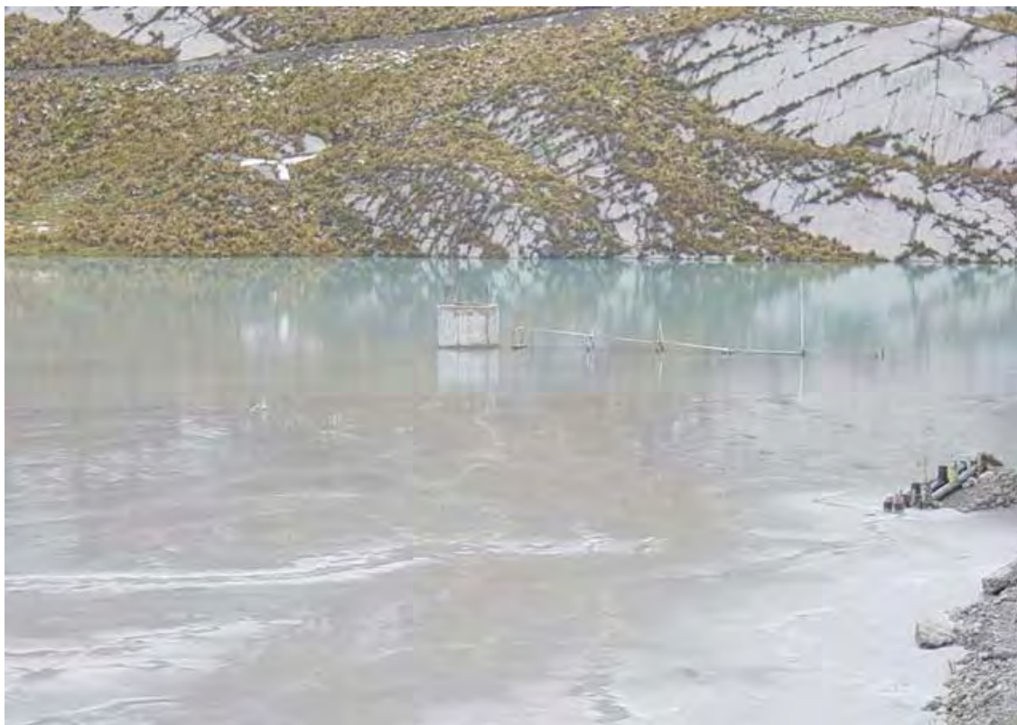
Foto 7-5: BUZONES DE CONCRETO POR DONDE SE EVACUA EL AGUA DEL ESPEJO DE LA RELAVERA
