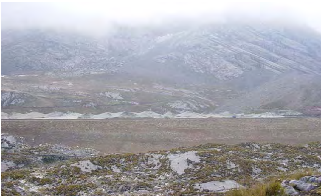
Foto 4-3: DEPOSITO DE RELAVES NIEVE UCRO II
