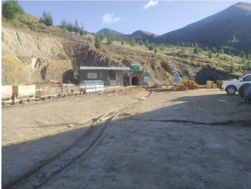
Bocamina principal nivel 4
