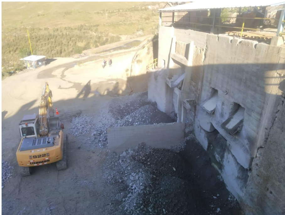
Cancha de mineral nivel 4
