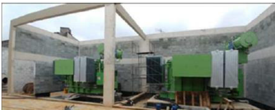
Figura 44. Instalación en terreno de transformadores de potencia en aceite vegetal Fuente: propia
