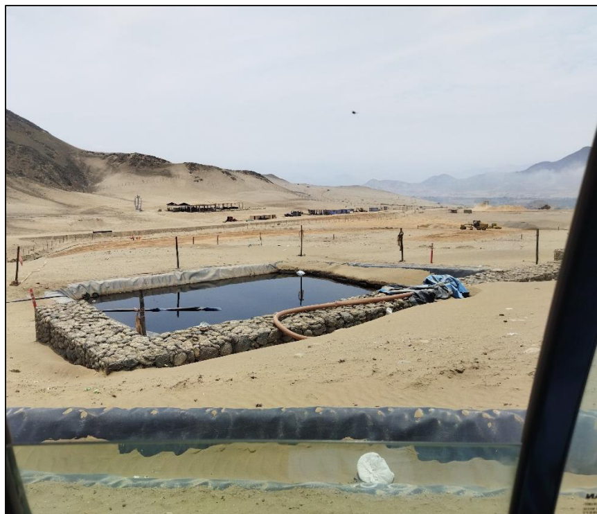
Poza de lixiviados de relleno sanitario de Chancay
