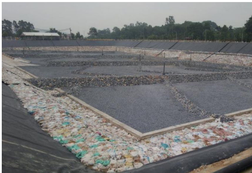
Ilustración N° 6: Construcción del relleno sanitario de Xuân Son en Hanoi, Vietnam
