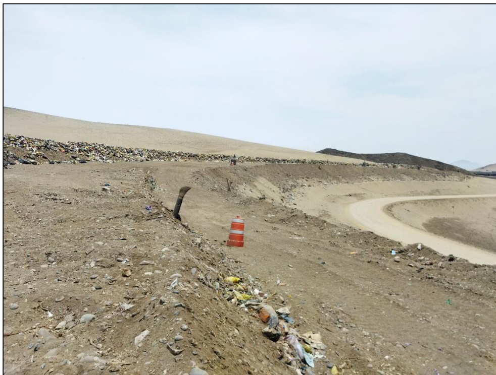
Celda 01 del relleno sanitario de Chancay
