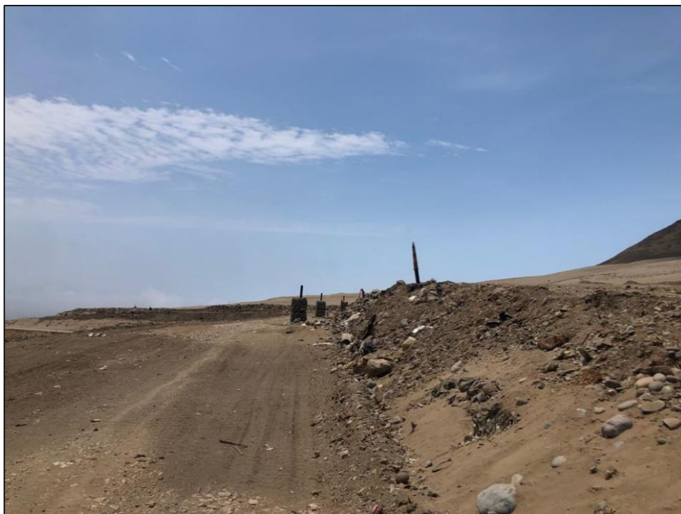
Zona compactada del relleno sanitario de Chancay
