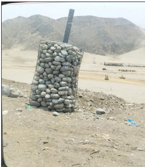
Chimenea del relleno sanitario de Chancay
