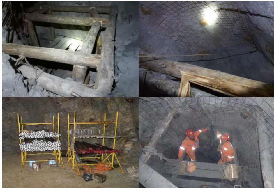
Fotografía N° 17. Sostenimiento con sobre cuadros y malla más Split set en Chimenea.
