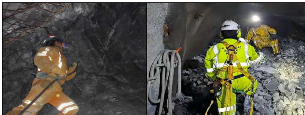
Fotografía N° 15.- Regado de carga corona en Chimenea
