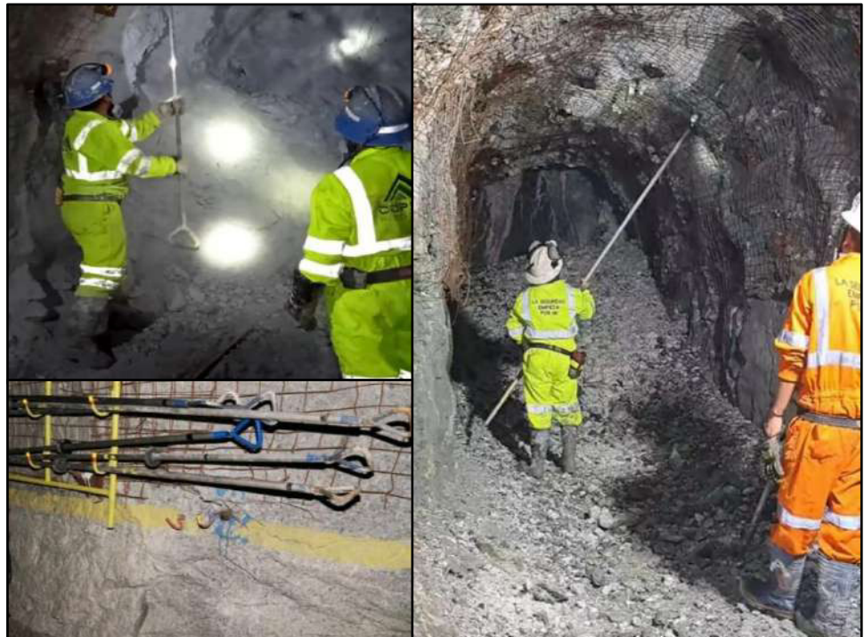
Fotografía N° 16. Desatado de rocas en Chimenea
