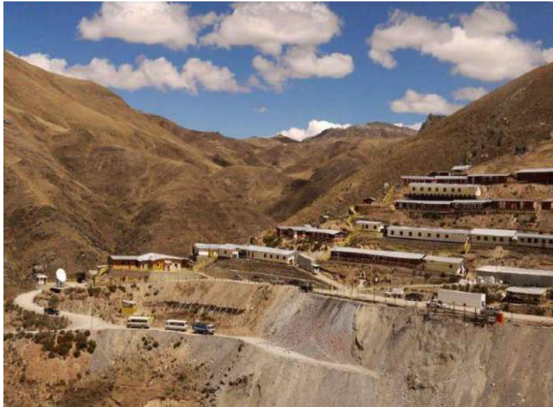
Fotografía N° 08. Vista de Oficinas U.E.A Mallay.
