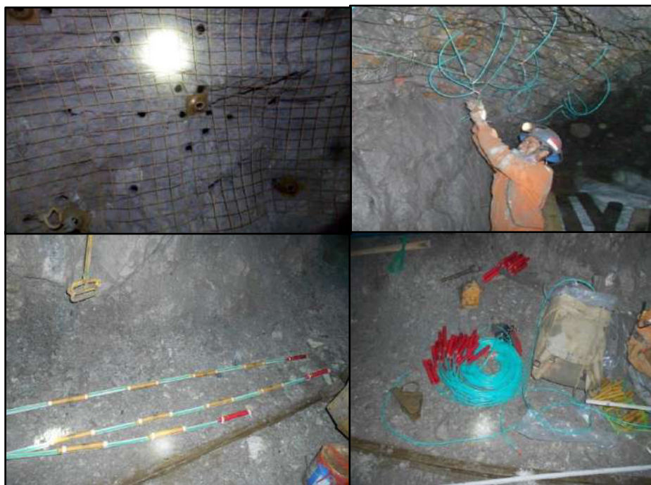
Fotografía N° 20. Carguío y voladura en chimenea
