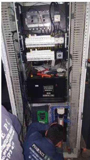
Figura 116 Armado de gabinete TFC-001. Fuente. Fotografía propia.
