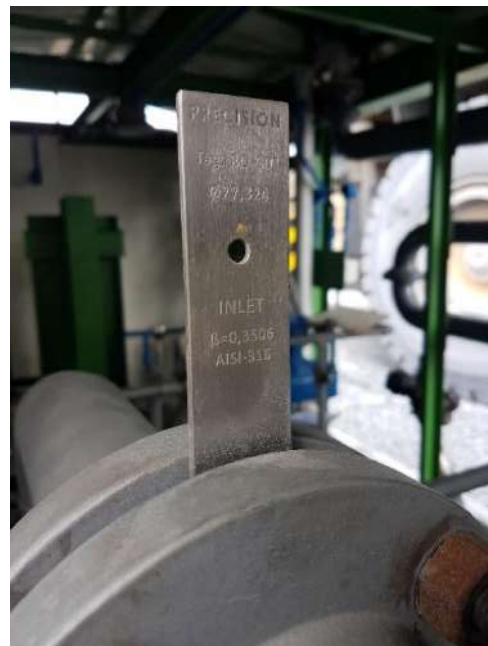
Figura 87 Orificio de restricción con ø=27.324 mm. Fuente. Fotografía propia.
