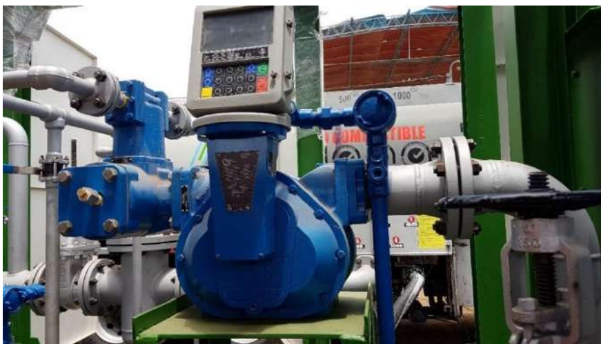
Figura 53 Medidor volumétrico QFIT en Skid. Fuente. Fotografía propia.
