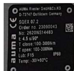
Figura 70 Placa de actuador SQ válvula motorizada. Fuente. Fotografía propia.
