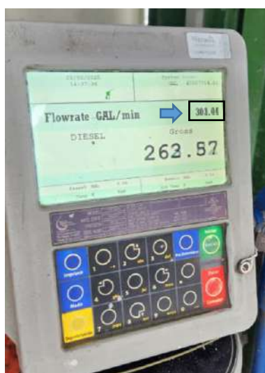
Figura 221 Medidor volumétrico iniciando operación, muestra flujo y acumulado. Fuente. Fotografía propia.
