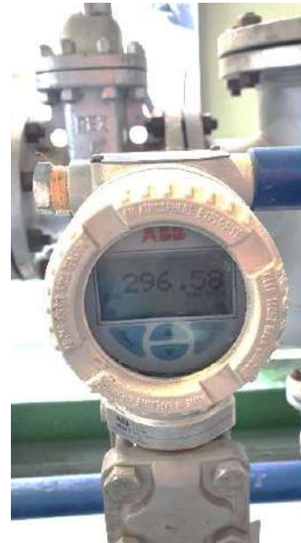
Figura 34 Medidor de flujo diferencial en operación. Fuente. Fotografía propia.
