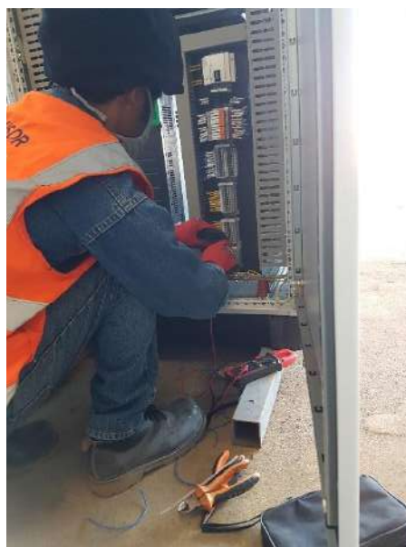
Figura 117 Pruebas de continuidad. Fuente. Fotografía propia.
