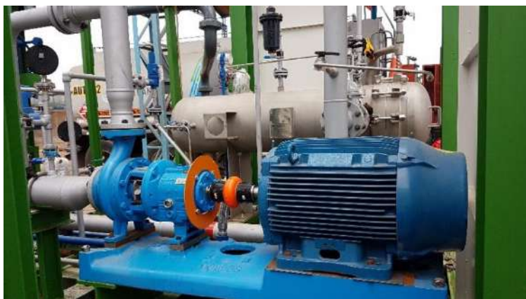
Figura 81 Bomba centrífuga acoplada a motor eléctrico. Fuente. Fotografía propia.
