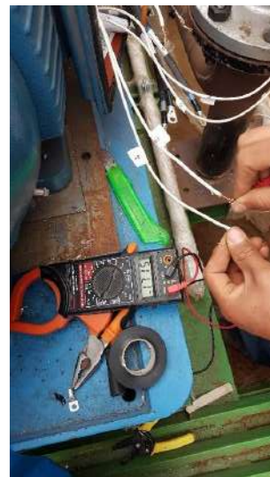
Figura 115 Tendido de cables para motor. Fuente. Fotografía propia.
