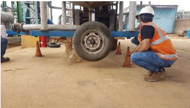
Figura 218 Nivelación de serafín 560 gal. Fuente. Fotografía propia.
