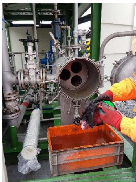
Figura 101 Apertura de filtro micrónico. Fuente. Fotografía propia.
