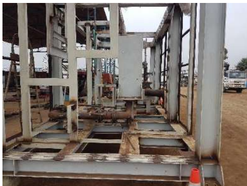
Figura 111 Fabricación y montaje de estructuras. Fuente. Fotografía propia.
