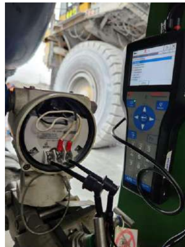
Figura 119 Comunicador Hart para configuración de transmisor. Fuente. Fotografía propia.
