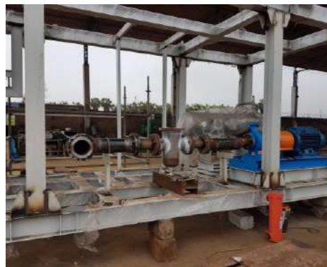
Figura 112 Fabricación de tuberías. Fuente. Fotografía propia.
