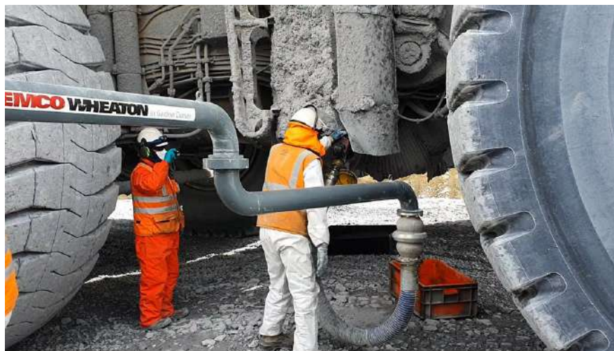
Figura 91 Colocación de pistola Wiggins. Fuente. Fotografía propia.
