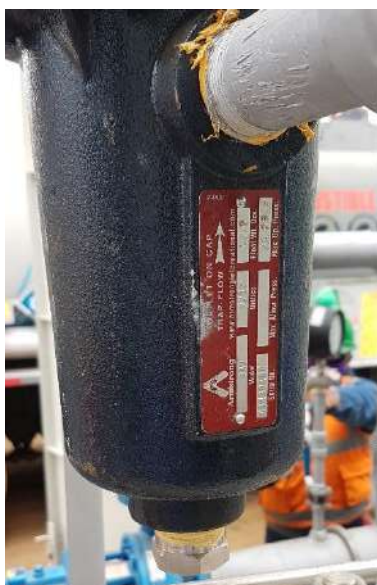
Figura 104 Placa de eliminador de aire 3-AV para filtro micrónico. Fuente. Fotografía propia.
