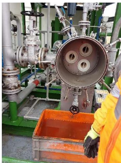
Figura 102 Instalación de cartuchos en filtro de fibra sintética. Fuente. Fotografía propia.
