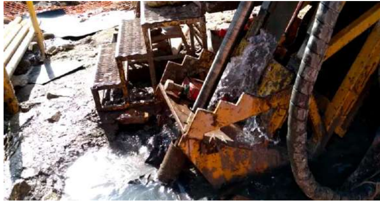
• Figura 63 Perforación geotécnica de despresurización.
