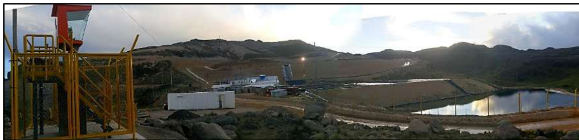
Figura 14 Caseta de monitoreo.
