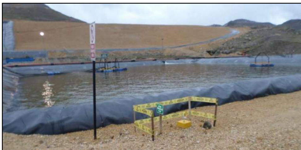
Figura 11: Fotografía de prismas y/o puntos de control.
