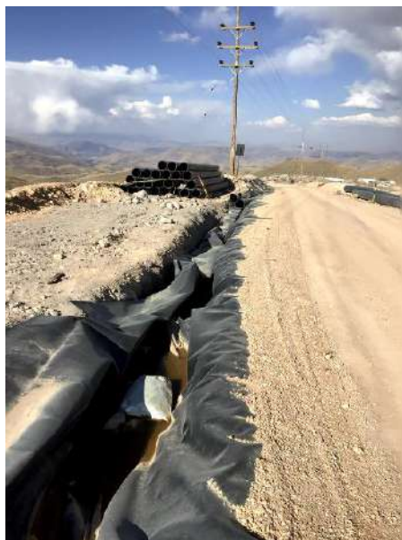
Figura 58 Canal perimetral en la zona norte del pad de lixiviación.
