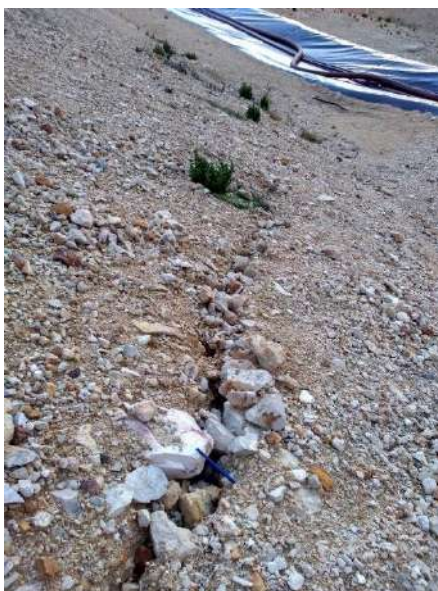
Figura 43 Grieta en los alrededores de las pozas.
