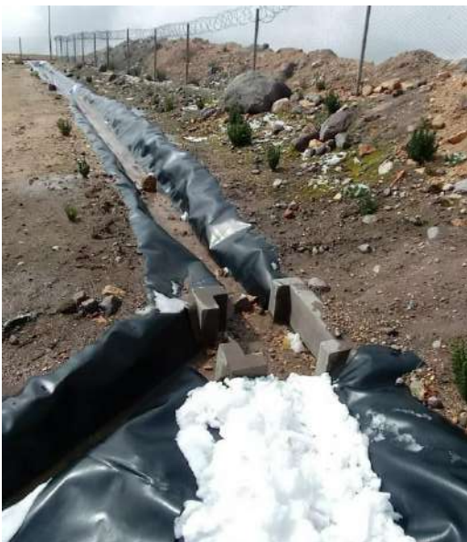
Figura 38 Mantenimiento de canal.
