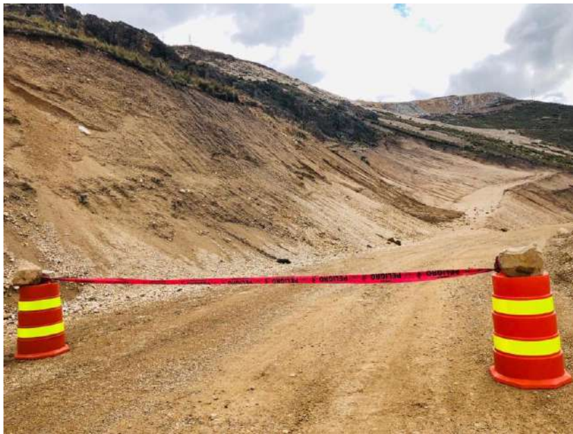
Figura 44 Zona sur de pad de lixiviación.
