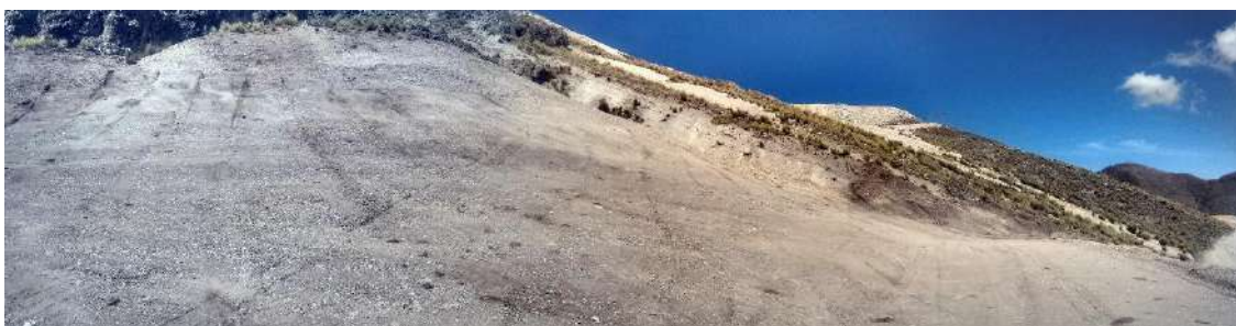
Figura 24: Perfilado de la zona sur del Pad de lixiviación.
