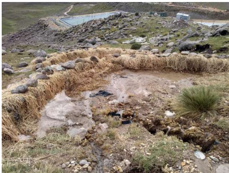
• Figura 53 Poza de sedimentación.
