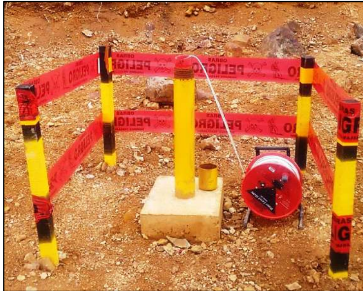
Figura 7: Monitoreo de nivel de agua.
