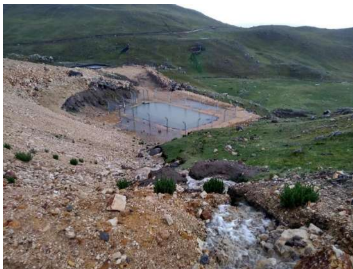
Figura 57 Desborde de la poza de sedimentación.
