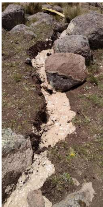
Figura 62 Grieta en la zona noroeste del pad de lixiviación.
