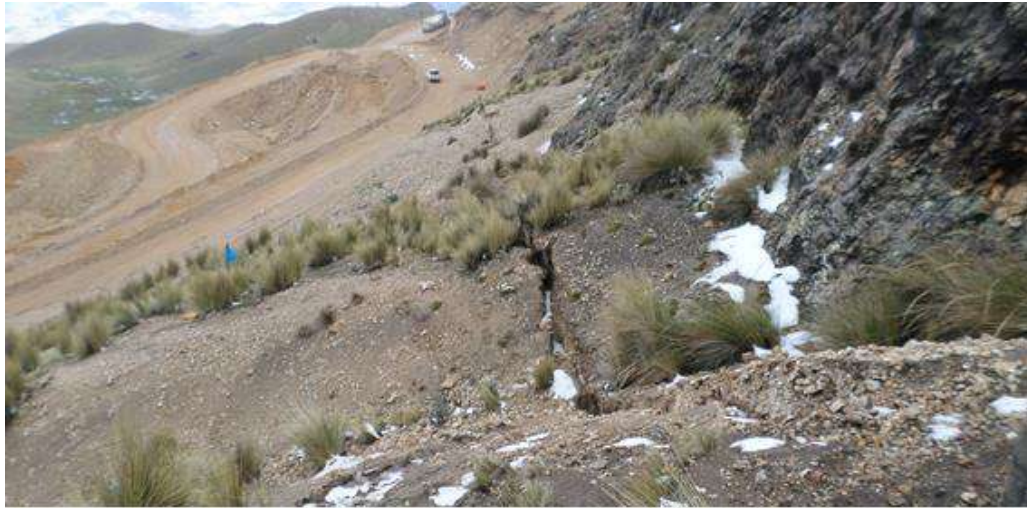
Figura 22: Zona sur del Pad antiguo.
