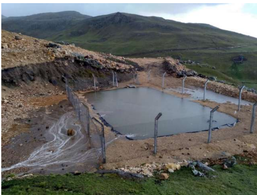
Figura 56 Poza de PTAR.
