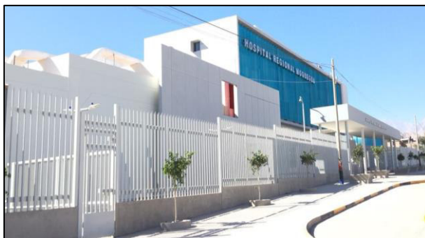
Figura 37. Fachada Frontal del Hospital Regional de Moquegua (ELABORACIÓN PROPIA)
