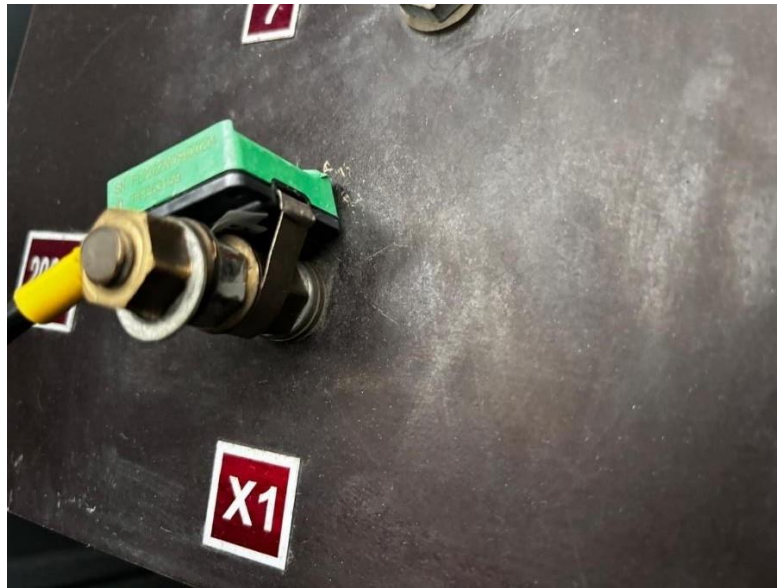
Figura 75: Sensor TH110 en la fase 1
