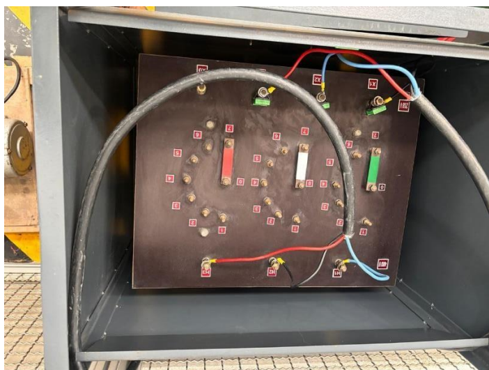
Figura 77: Instalación de los sensores en el transformador
