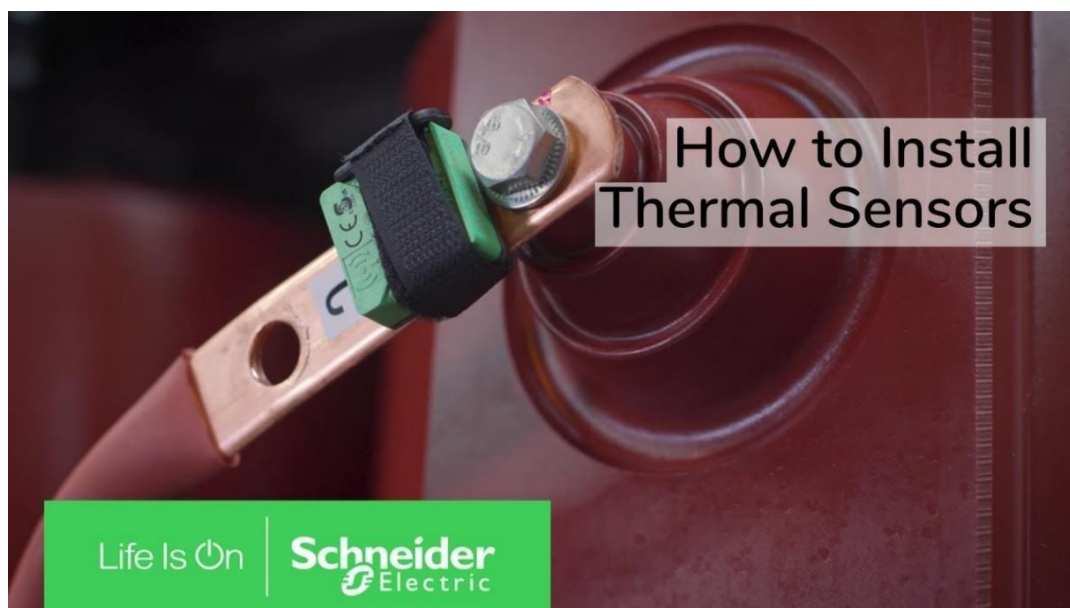
Figura 76: Instalación según manual del sensor TH110
