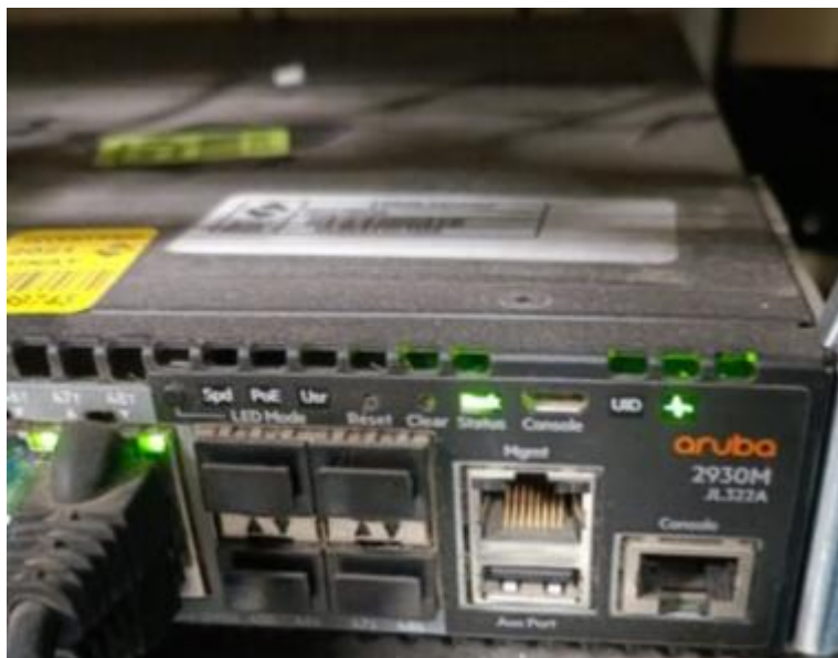
Figura 10 Swich PoE Aruba 48 puertos Fuente. Fotografía tomada al dispositivo.
