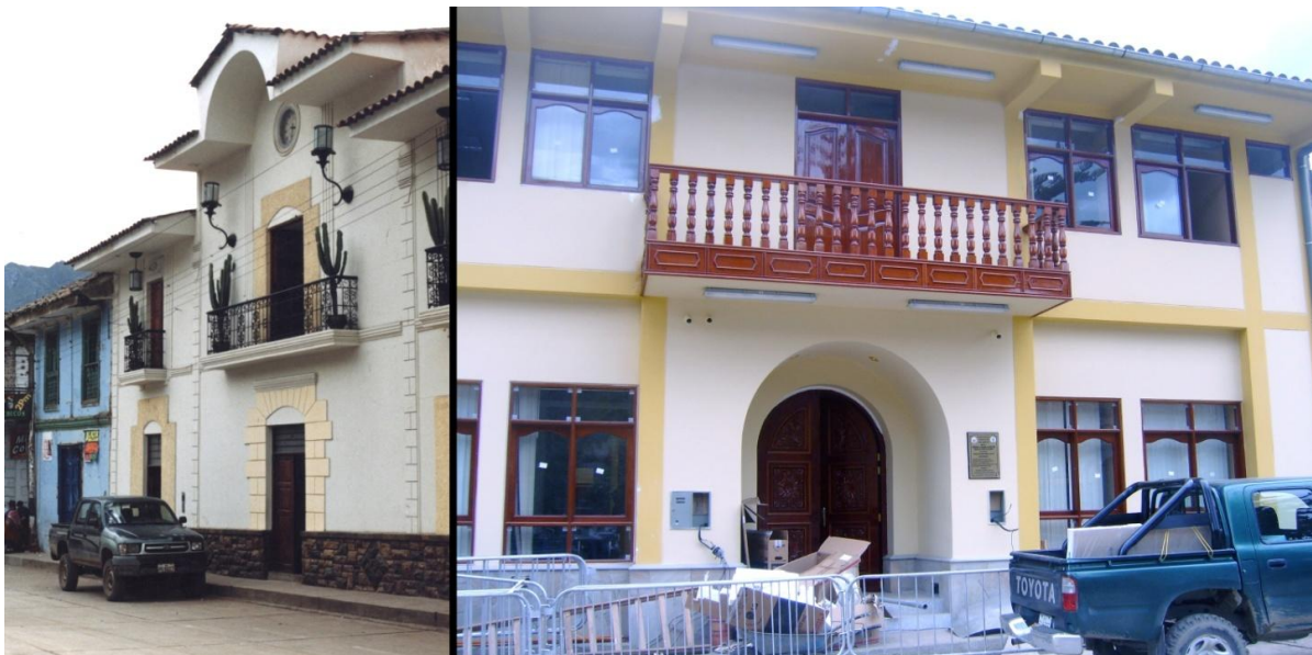
21. Cambios ante actividad minera: local de la municipalidad distrital en 2004 (izquierda) y nuevo local municipal en construcción en 2009 (derecha).
