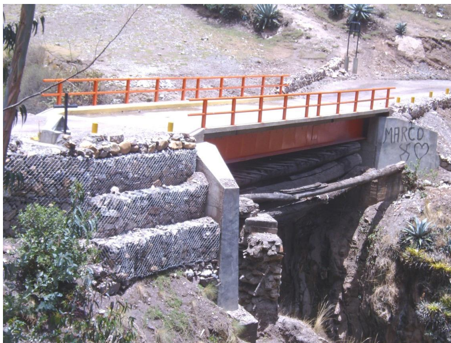
20. Cambios ante actividad minera: puente de concreto construido en las afueras de Chullush. Abajo puede notarse las maderas del puente anterior. Año 2009.
