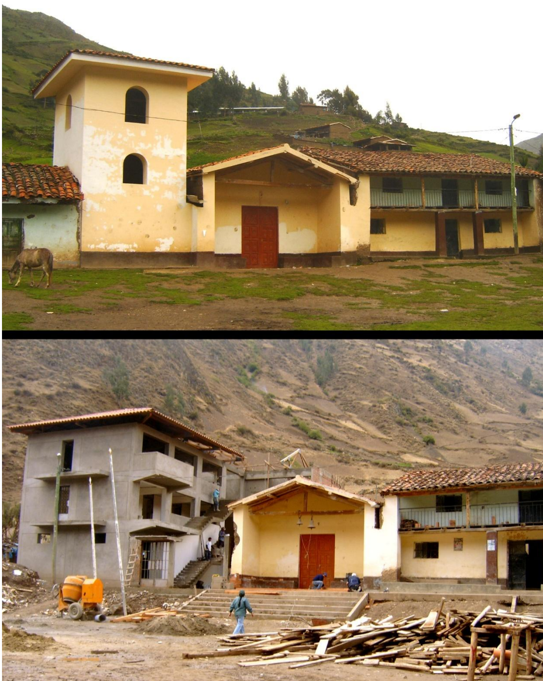
23. Cambios ante actividad minera: plaza central de Challhuayaco con local de la municipalidad de centro poblado, capilla y escuela en el año 2008 (arriba). La misma plaza en 2009, durante la construcción del nuevo local de la municipalidad de tres pisos. La torre de la capilla había sido demolida, pero la escuela aún se conservaba (abajo).
