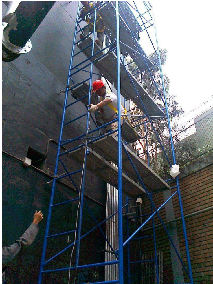
FIGURA N º 4.4: INTERVENCION DE INCOL EN OBRA DE TELEFONICA DE MONTERRICO
