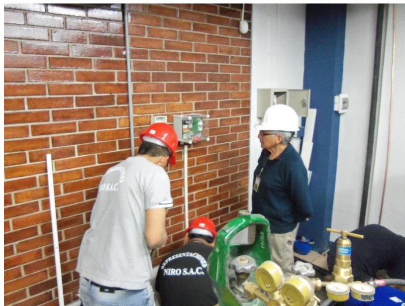
FIGURA N° 4.5: INTERVENCION DE INCOL EN OBRA DE SIMA CALLAO
