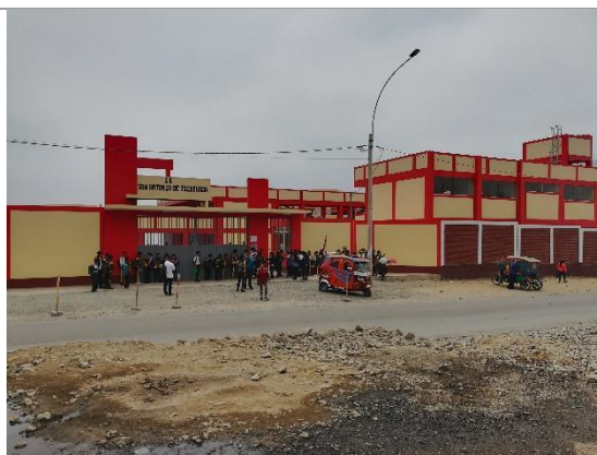
Foto 29. Colegio nacional San Antonio de Jicamarca, inaugurado a inicios del año 2018. Está ubicado en el sector Cercado y tiene capacidad para acoger gran cantidad de alumnos. Obsérvese los mototaxis que dejan a los estudiantes en el colegio. Fuente: archivo personal, noviembre 2018.
