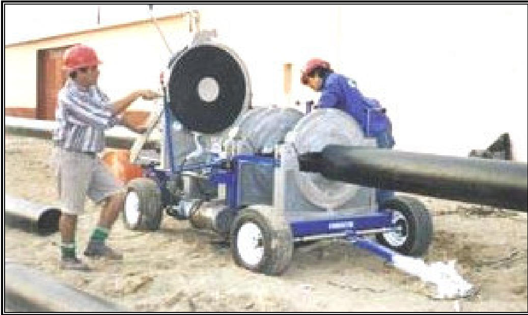
Fig.20 Soldadura por Termofusión de Tuberías de Polietileno
