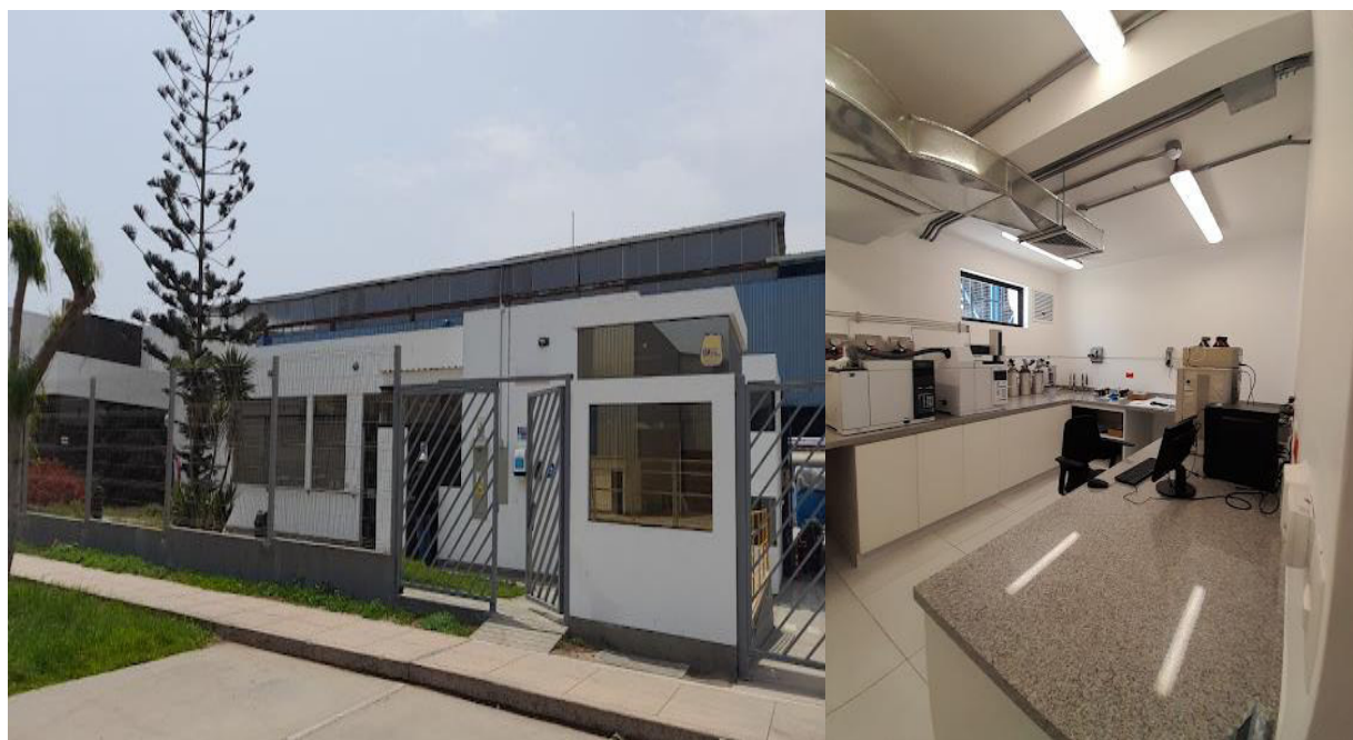
Figura 1. Planta Hitachi Energy, Kapala, cercado de Lima 15823.
