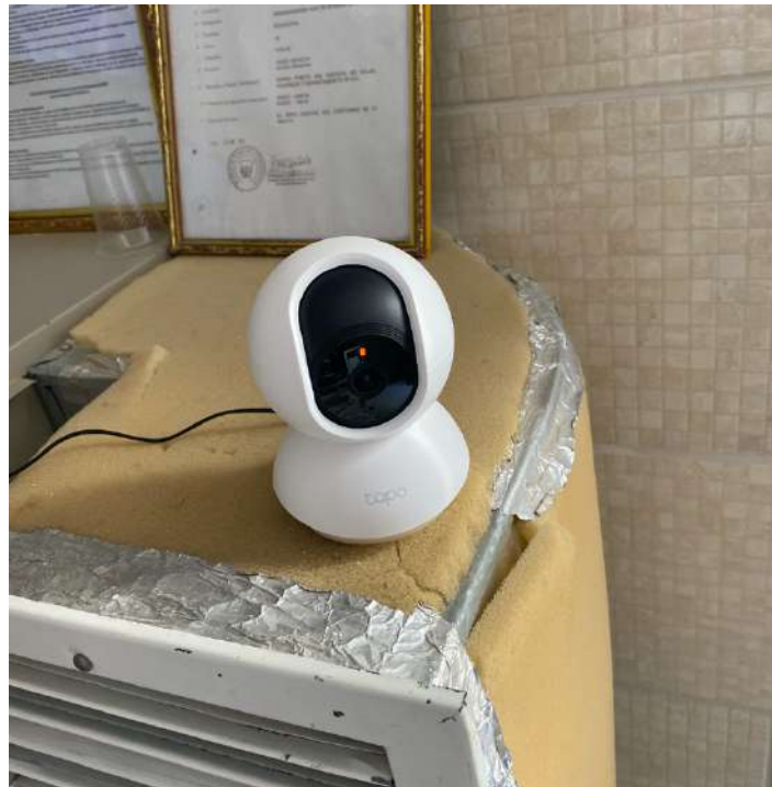
Figura 22. Instalación de cámara IP Tapo. Fuente: Elaboración propia
