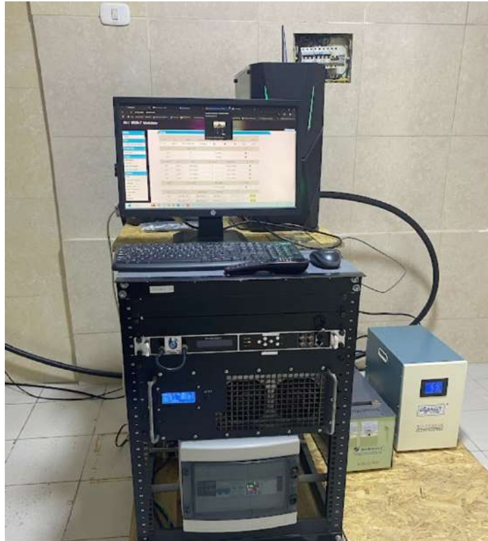
Figura 20. Instalación de PC en planta. Fuente: Elaboración propia
