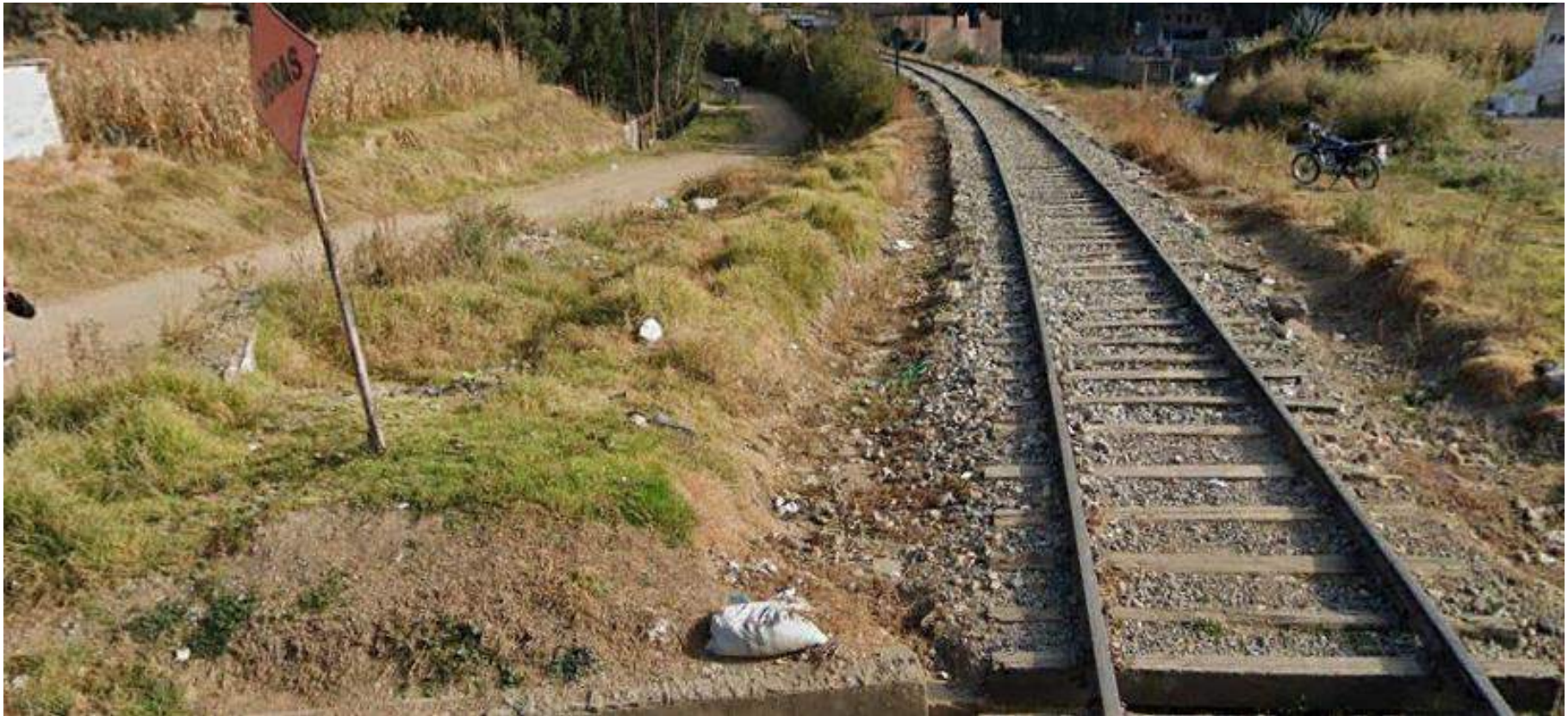
Foto N°7: Línea ferrea actual y vía de acceso a la comunidad..
