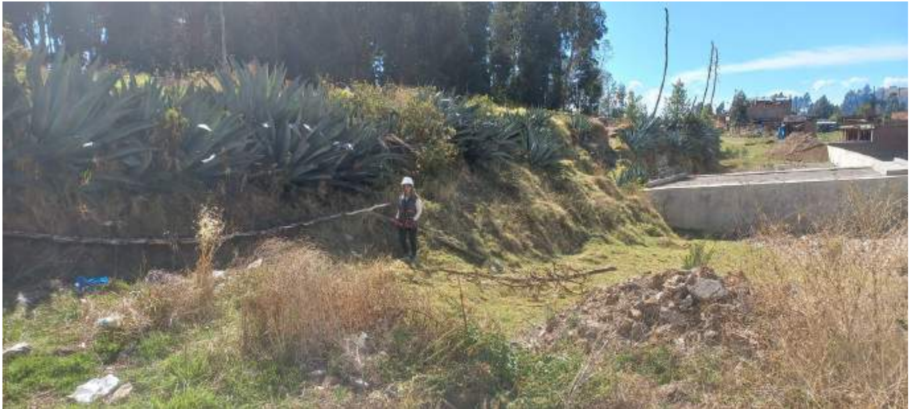
Foto N°5: Vista del talud de estudio..
