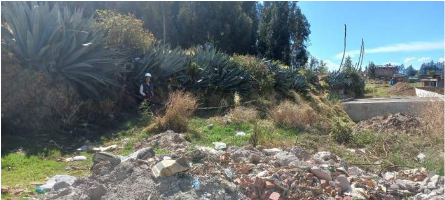
Foto N°4: Vista lateral derecha del talud de estudio.
