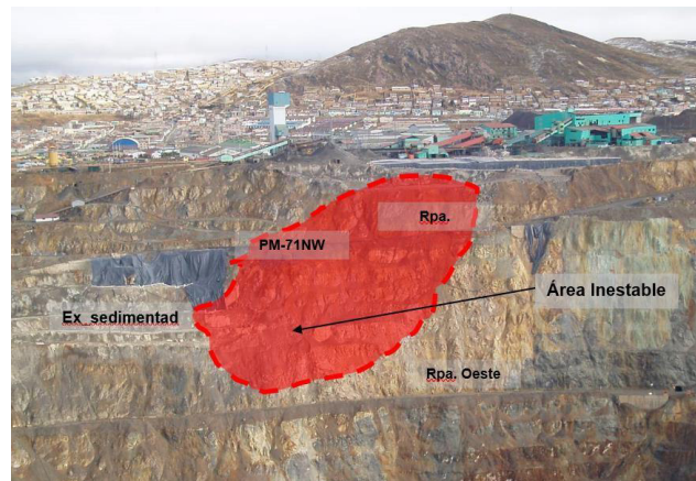
Figura 5. Vista mirando al Noroeste, señalizando la zona inestable.
