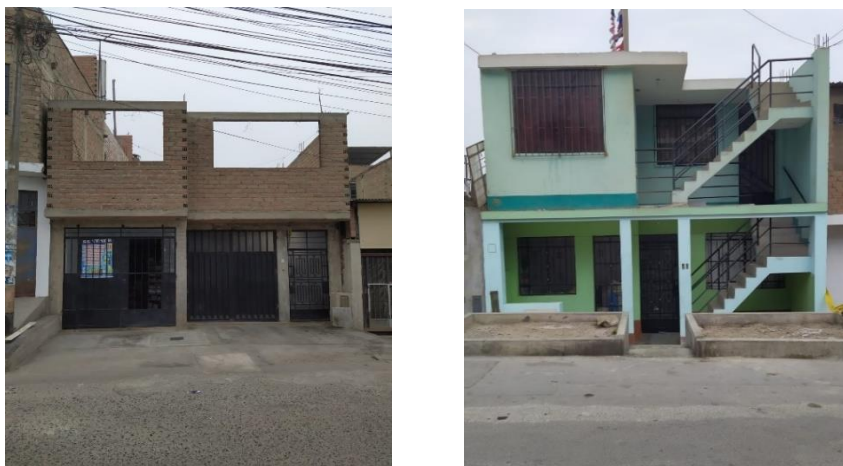
Figura 6: Fachadas de cuatro de las viviendas visitadas en el AA.HH San Fernando.
