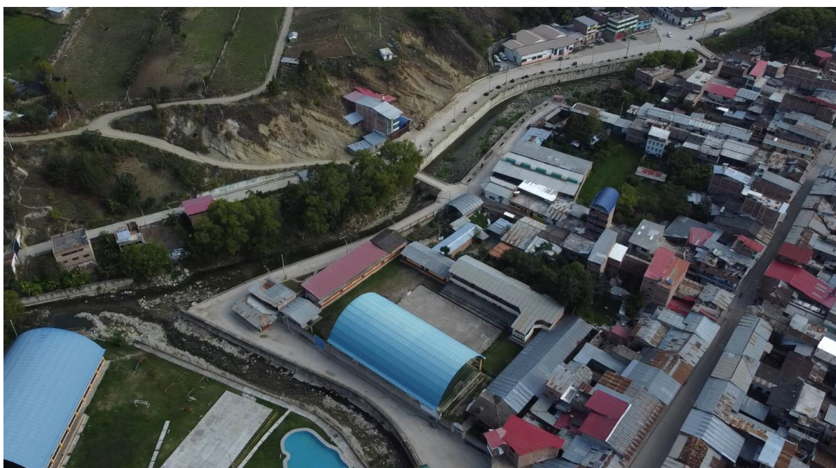
Figura 41 Fotografía aérea de la zona de la confluencia del río Chotano
