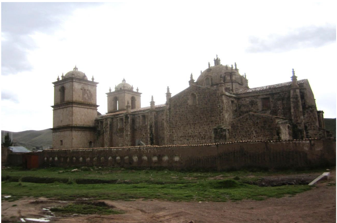
Foto 02: Vista lateral de la iglesia de Santiago de Pupuja. Tomada el 29-01-2015
