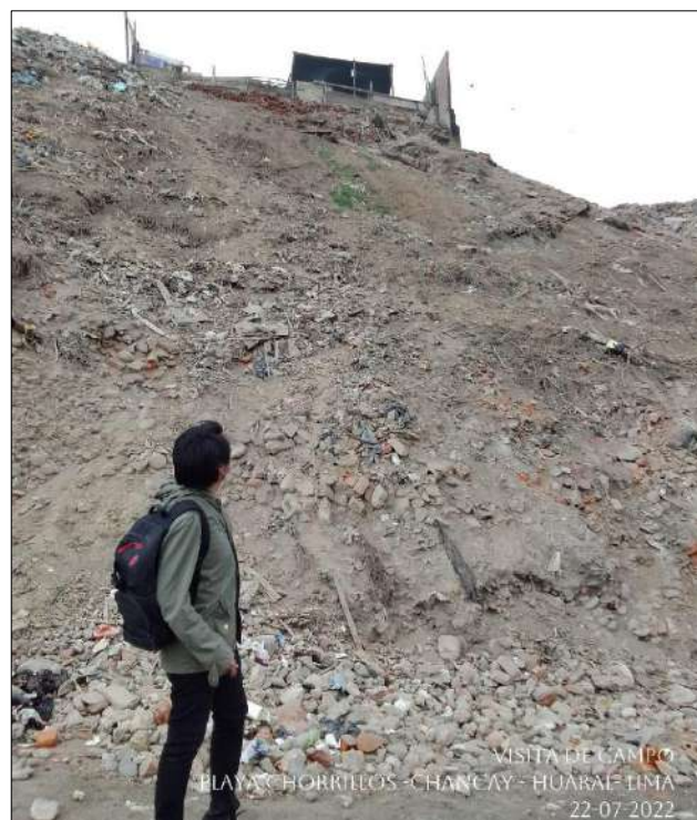
Figura 22. Observación de los taludes más críticos. El Autor (2022)
