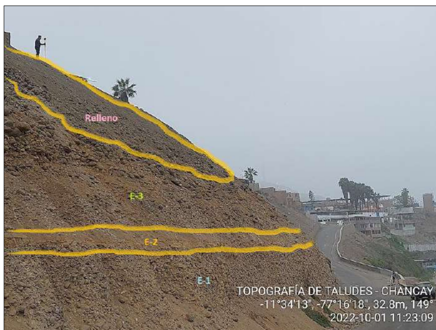
Figura 26. Definición de estratos para la extracción de muestra de suelo, progresiva KM 0+300. El Autor (2022)
