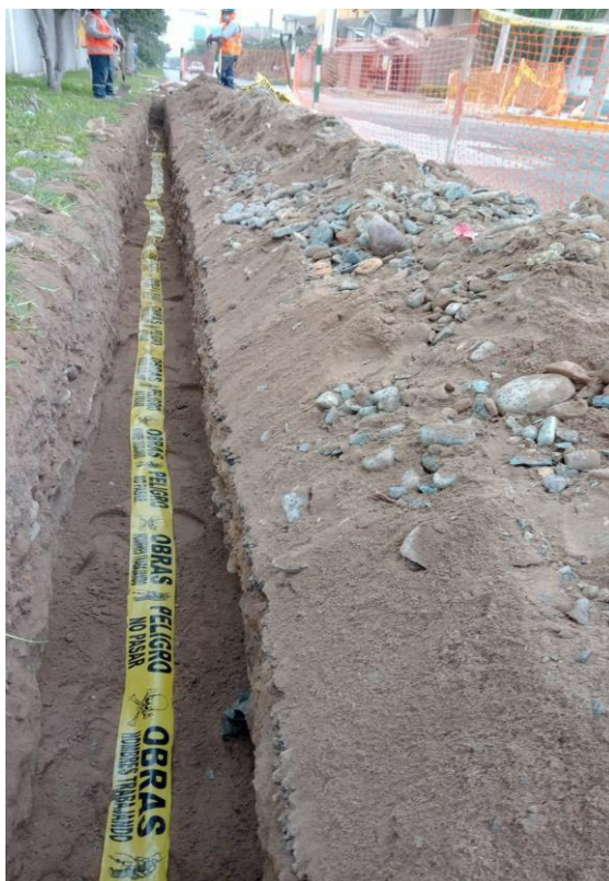
Figura 33: Instalación de cinta amarilla – recorrido de acometida eléctrica. Fuente: Archivo fotográfico de Clear Channel.
