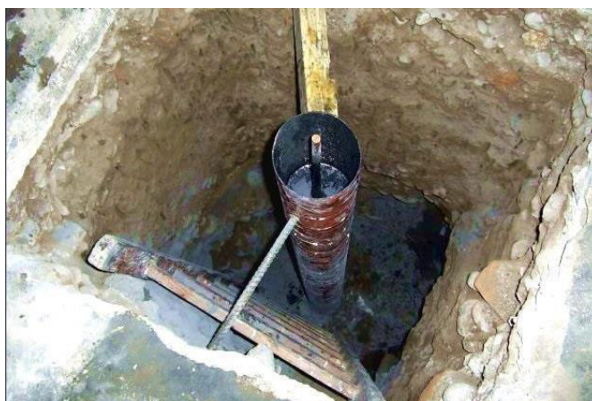
Figura 37: Instalación de varilla de cobre y cemento conductor. Fuente: Archivo fotográfico de Clear Channel.
