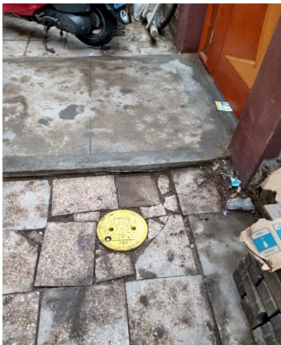
Figura 38: Instalación de caja de registro. Fuente: Archivo fotográfico de Clear Channel.
