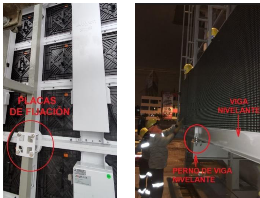
Figura 44: Nivelación de cabinets. Fuente: Archivo fotográfico de Clear Channel.
