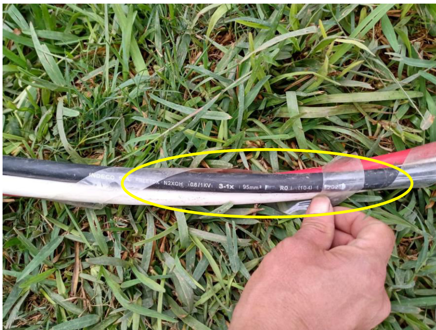
Figura 30: Verificación del conductor 3-1x95 mm 2 N2XOH. Fuente: Archivo fotográfico de Clear Channel.
