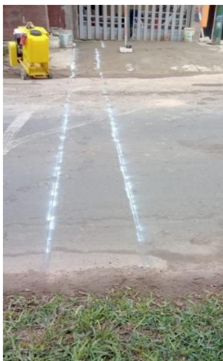
Figura 27: Trazado, corte y rotura de asfalto y losa de concreto. Fuente: Archivo fotográfico de Clear Channel.
