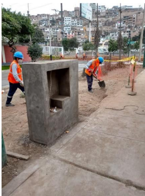
Figura 26: Construcción de murete para suministro. Fuente: Archivo fotográfico de Clear Channel.
