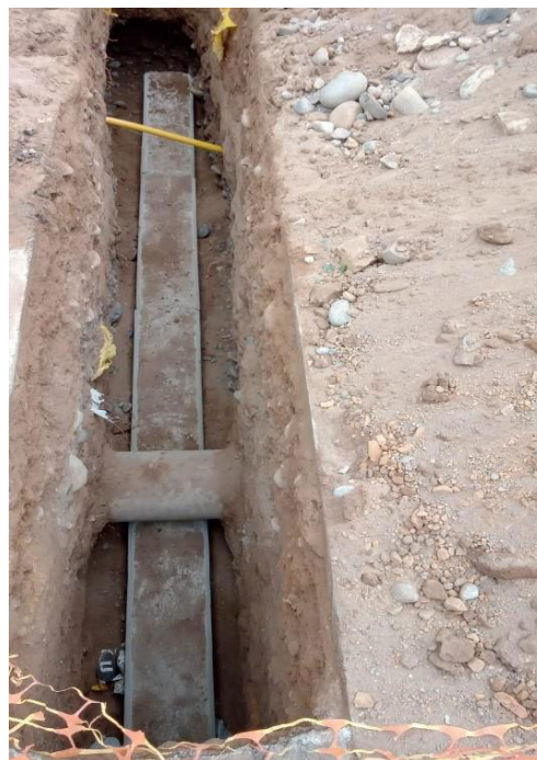
Figura 29: Instalación de ducto de concreto en cruce de pista. Fuente: Archivo fotográfico de Clear Channel.
