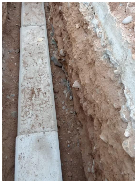
Figura 29: Instalación de ducto de concreto en cruce de pista. Fuente: Archivo fotográfico de Clear Channel.
