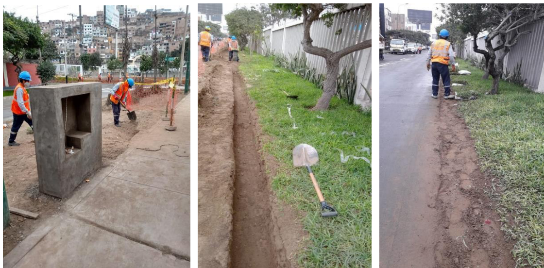
Figura 34: Relleno con tierra cernida y compactada hasta nivel de piso. Fuente: Archivo fotográfico de Clear Channel.
