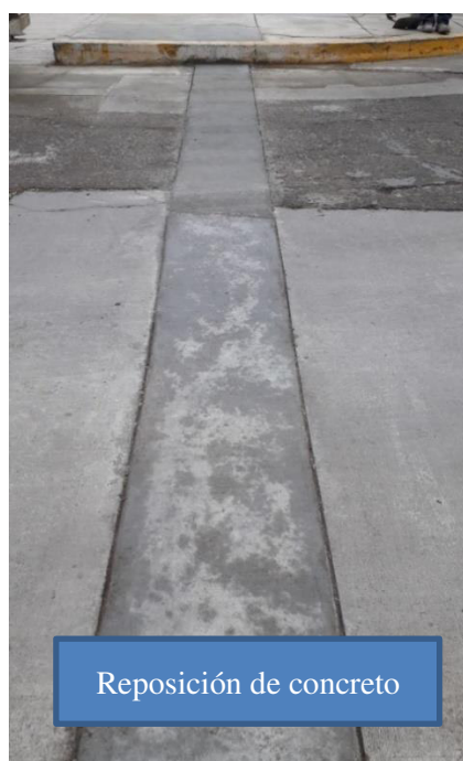
Figura 35: Reposición de asfalto, losa de concreto y grass. Fuente: Archivo fotográfico de Clear Channel.
