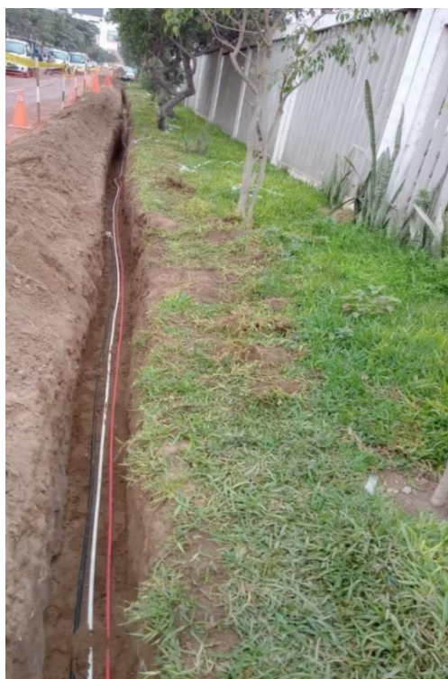
Figura 31: Tendido de acometida eléctrica. Fuente: Archivo fotográfico de Clear Channel.
