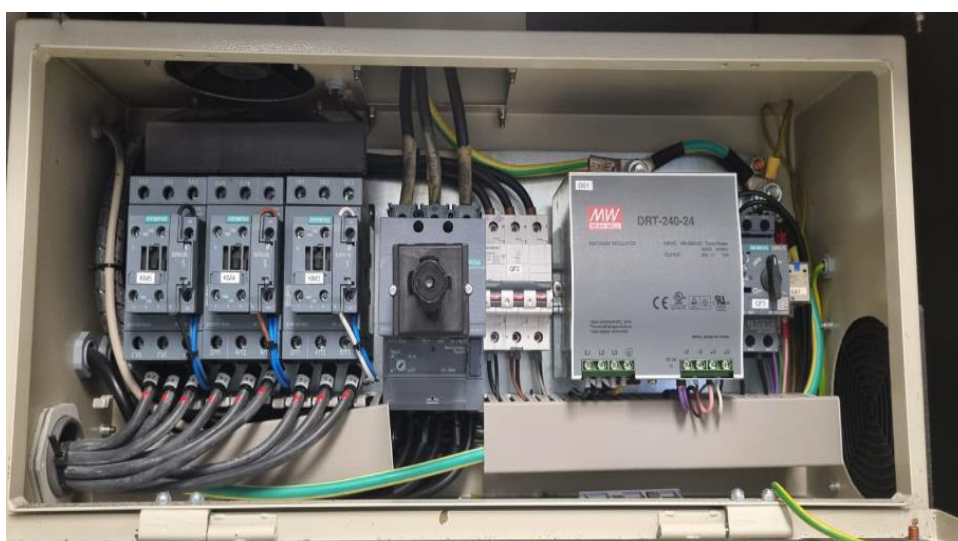
Figura 31 Sustitución de contactores de resistencia de generador a vapor. Fuente: Elaboración propia.
