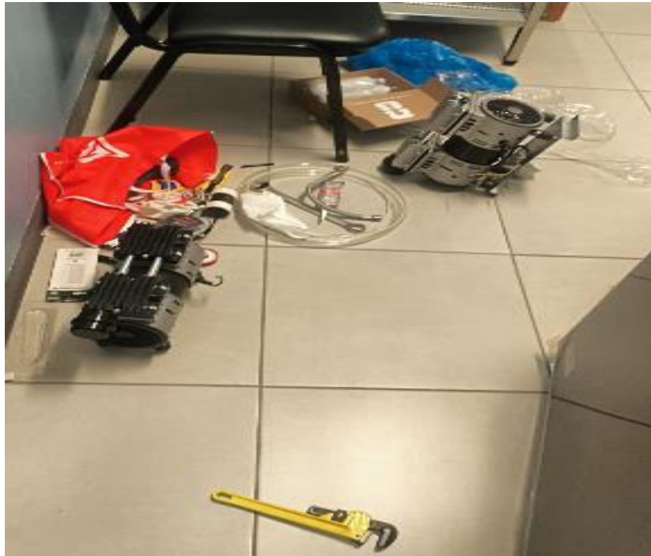
Figura 34 Reemplazo de compresor de sistema de aire comprimido.
