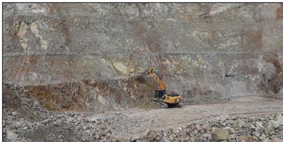
Evidencia de desatado banco 4660 al 4665 Banco Minero.
