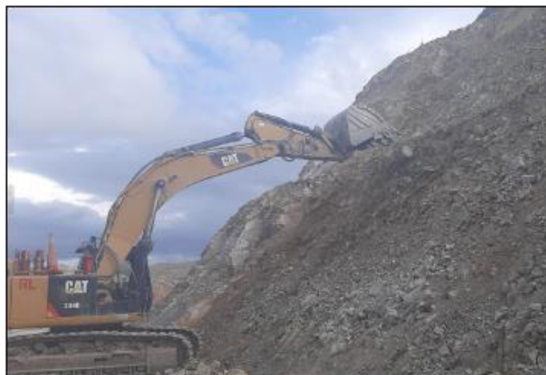
Evidencia de desatado banco 4665 al 4670 Banco Minero.
