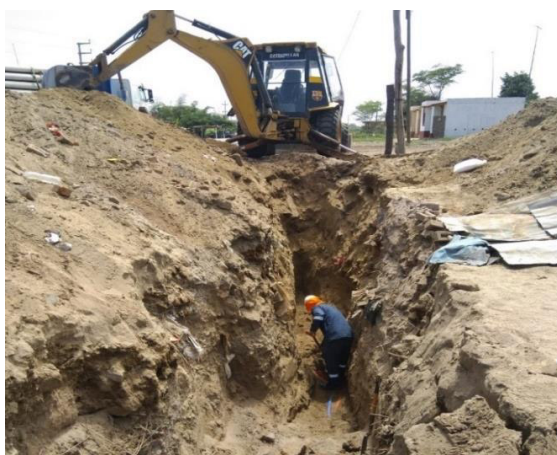
Figura 16: Construcción del canalizado usando maquinaria pesada. Fuente: Elaboración Propia
