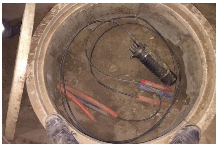
Figura 17: Instalación de mufa en el interior de una cámara. Fuente: Elaboración Propia
