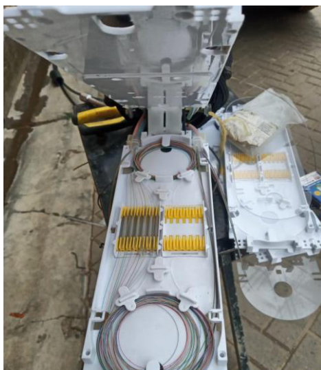
Figura 20: Bandejas internas de una mufa domo tipo bala. Fuente: Elaboración Propia
