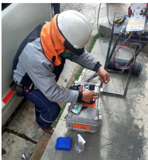
Figura 21: Personal capacitado usando la maquina fusionadora. Fuente: Elaboración Propia
