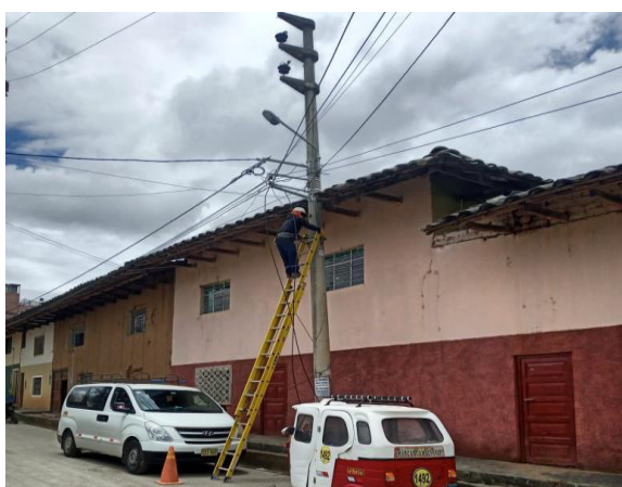
Figura 14: Instalación de F.O en poste de la LMT. Fuente: Elaboración Propia
