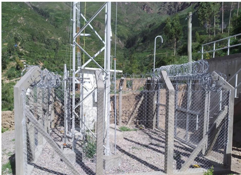
Figura 21: Reconstrucción del nodo Cocas finalizada. Fuente: Informe de construcción del nodo Cocas.
