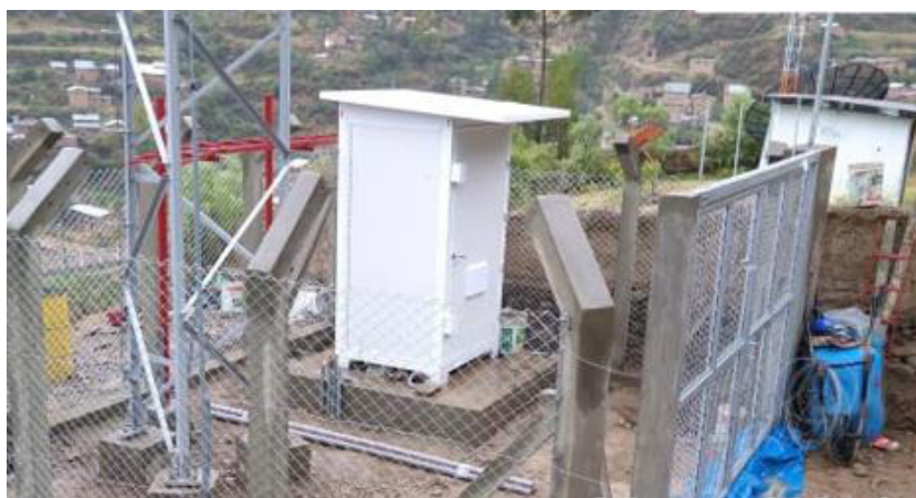
Figura 18: Instalación del Shelter. Fuente: Informe de construcción del nodo cocas.
