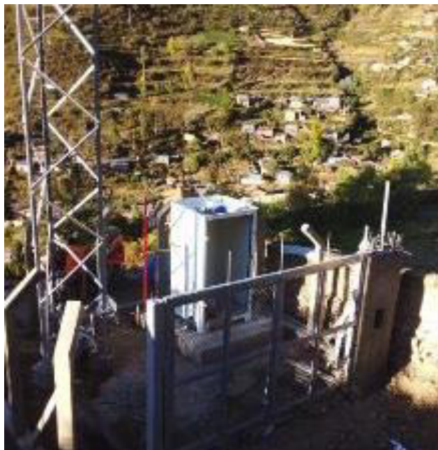
Figura 16: Instalación del shelter. Fuente: Informe de construcción del nodo Cocas.
