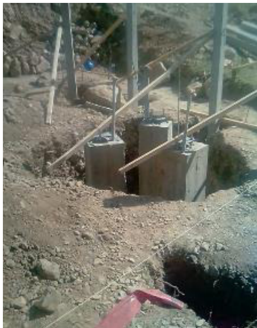
Figura 15: Instalación de bases de la torre. Fuente: Informe de construcción del nodo Cocas.
