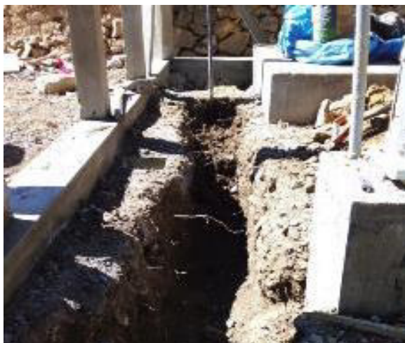
Figura 17: Excavación para Interconexión de pozos. Fuente: Informe de construcción del nodo cocas.
