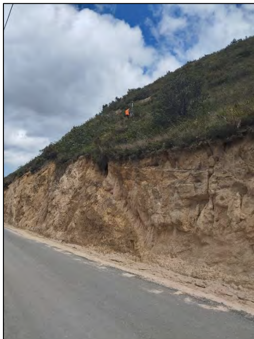
Figura 28. Ladera escarpada, ubicada en el Sector de Mejoramiento, SM-09.
