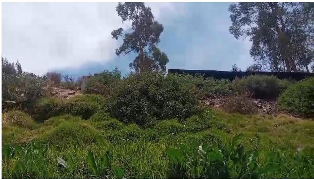
Ilustración 5. Reservorio de acumulación de las aguas servidas para desembocar de forma natural hacia el río Grande.
