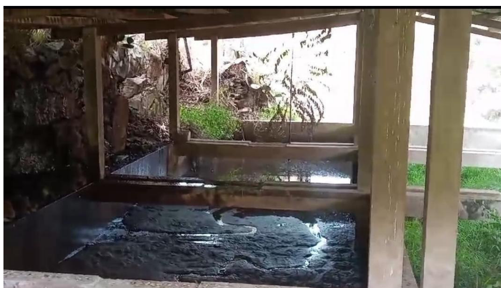
Ilustración 6. Pozo de almacenamiento de aguas servidas de Laramate.
