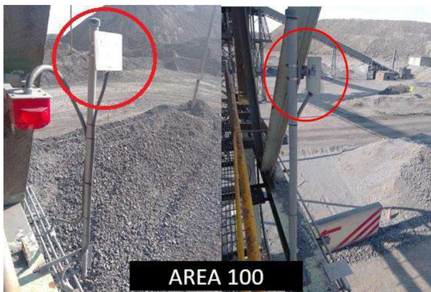
Figura 37: Antenas montadas en el área 100. Fuente: Elaboración propia (2025).
