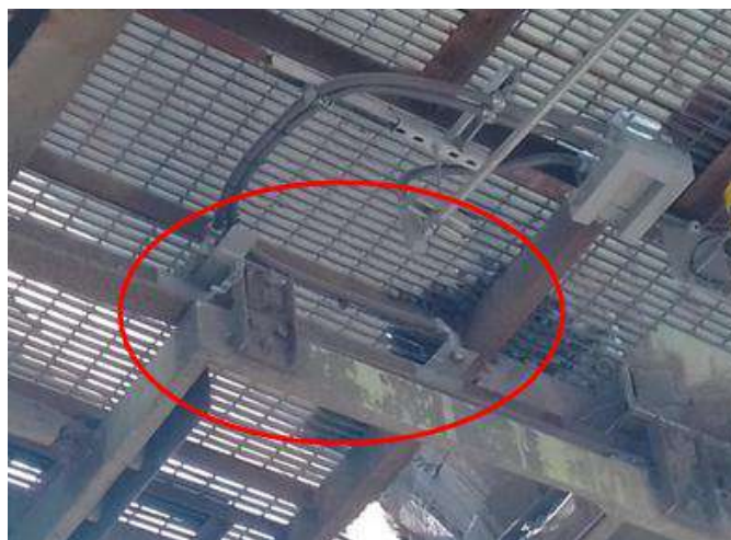
Figura 41: Sensores de posición inductivos ZS10001 y ZS10002. Fuente: Elaboración propia (2025).
