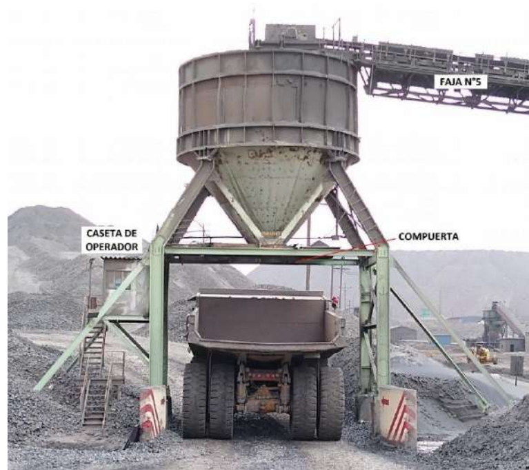
Figura 7: Tolva de material estéril. Fuente: Elaboración propia (2025)
