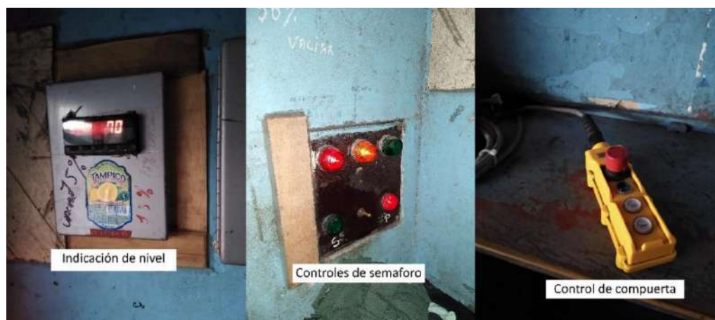
Figura 8: Controles existentes en el área 100. Fuente: Elaboración propia (2025)
