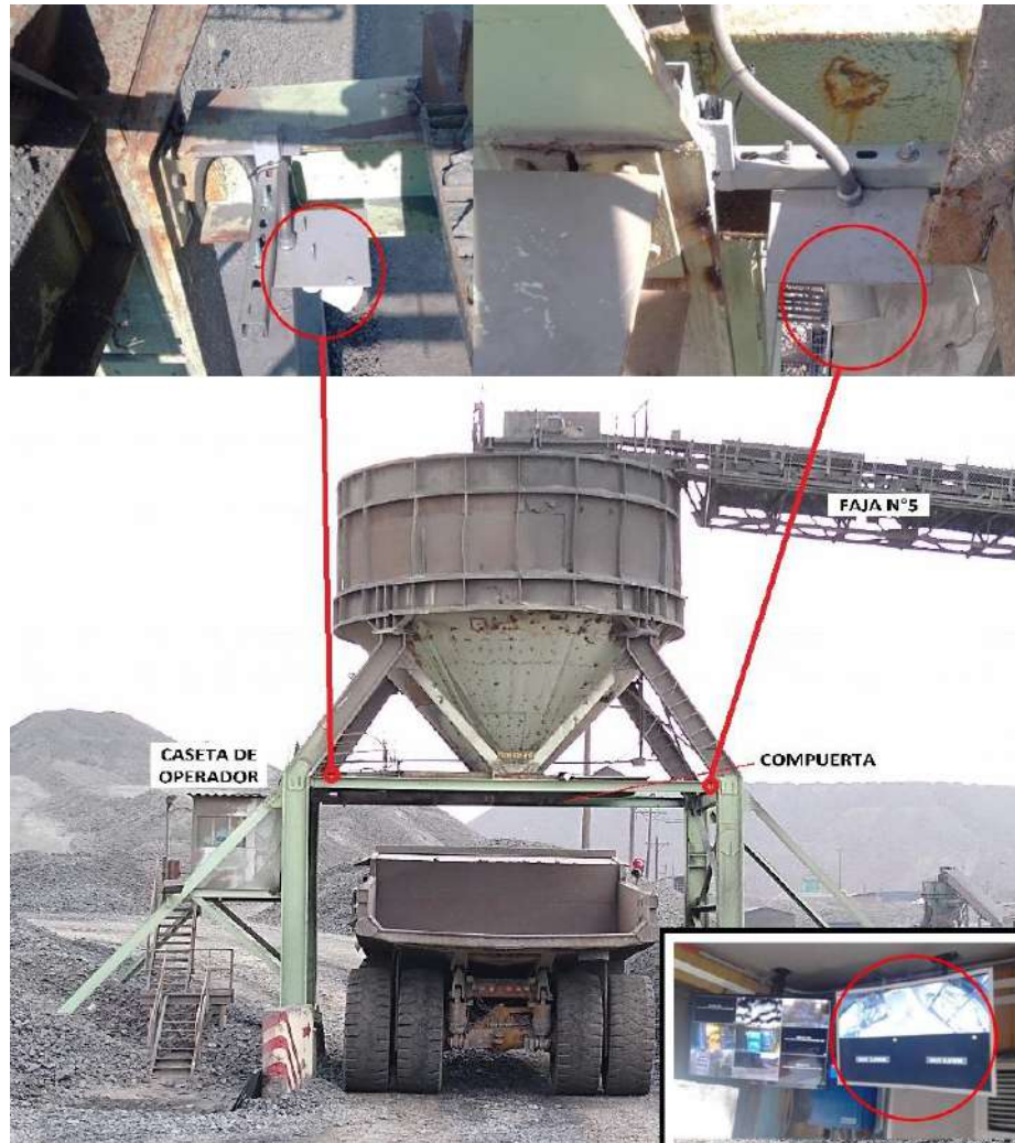
Figura 43: Cámaras y CCTV en sala de control. Fuente: Elaboración propia (2025).
