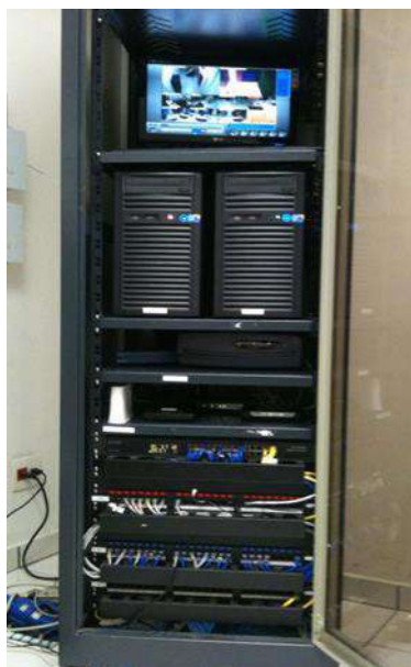
Figura 5 Gabinete de telecomunicaciones referencial (Fuente: Internet)
