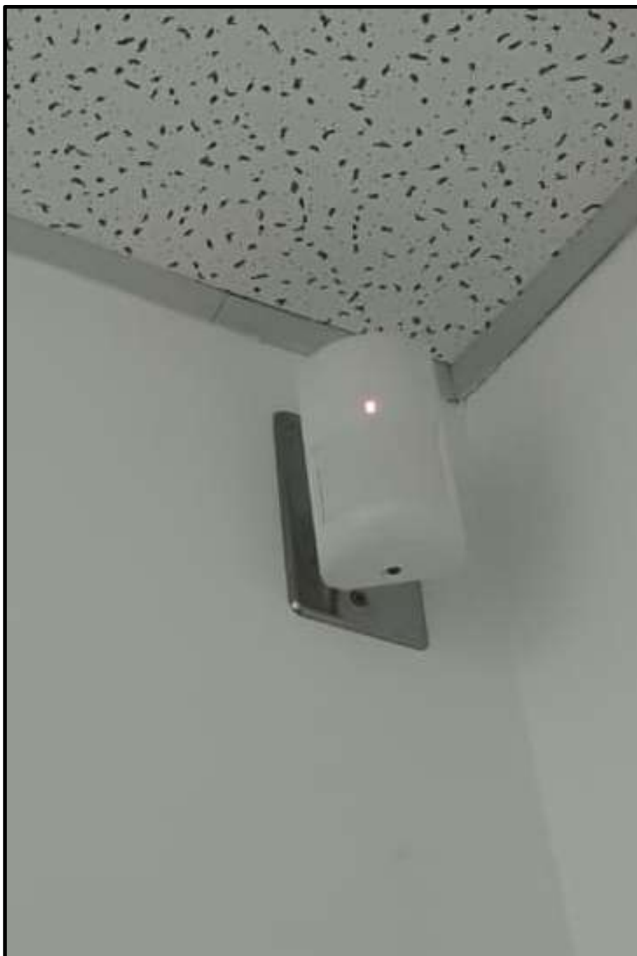
Figura 54 Sensor de movimiento “Pir 90°” . Fuente: Elaboración propia a partir de registro fotográfico tomado por Ángel Guerrero (2025).
