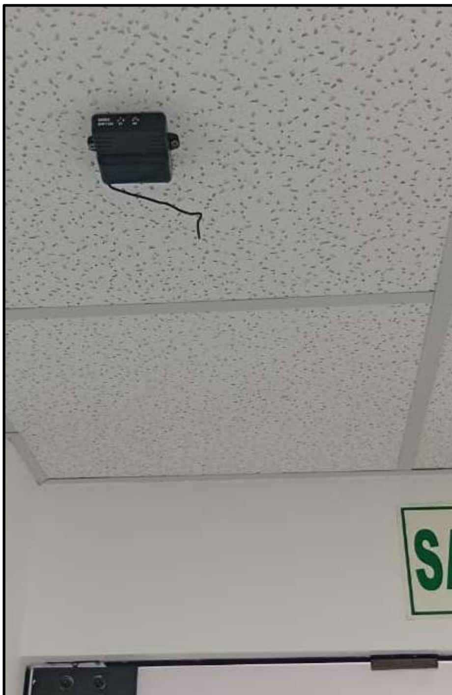
Figura 53 Receptor inalámbrico en ingreso de agencia. Fuente: Elaboración propia a partir de registro fotográfico tomado por Ángel Guerrero (2025).
