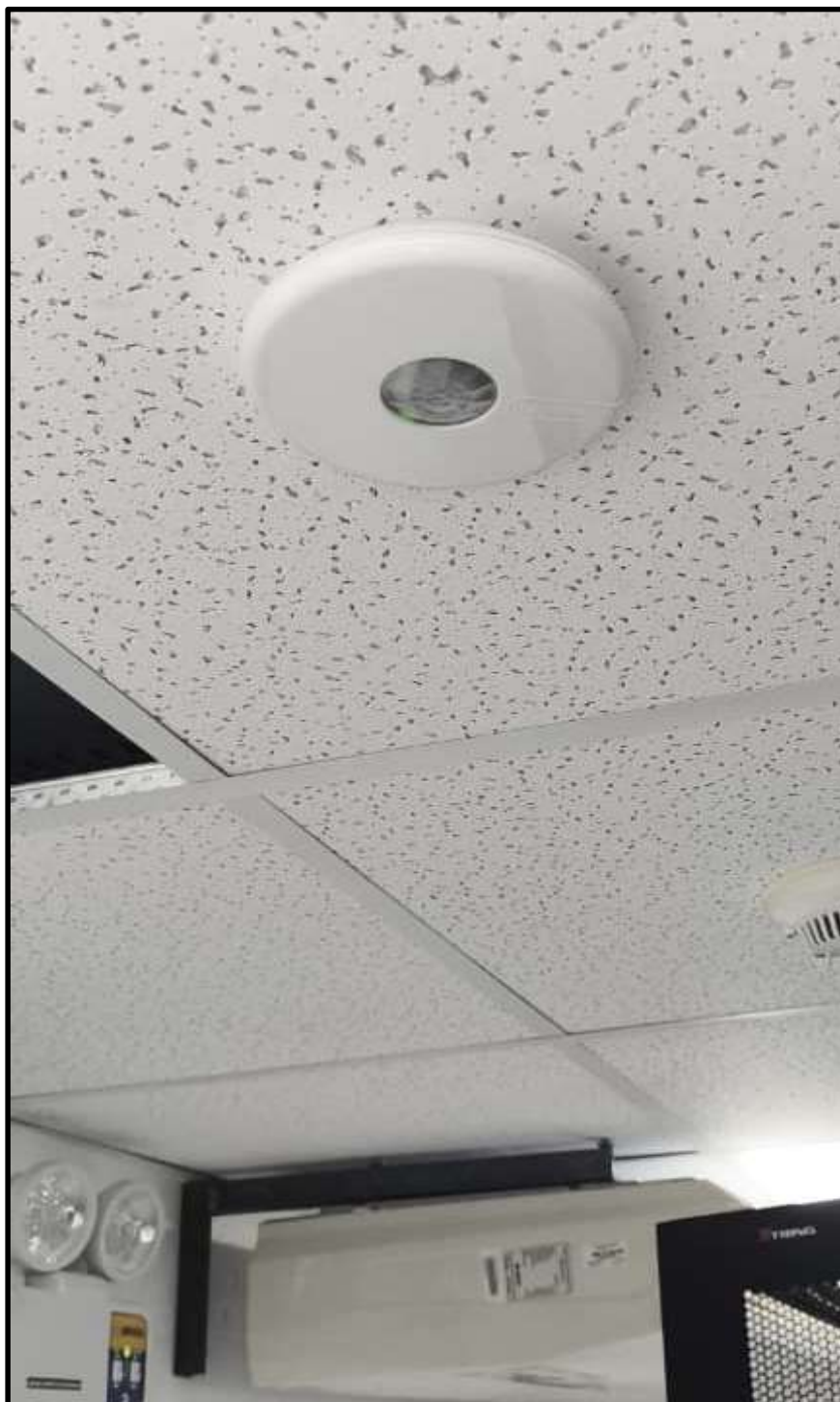
Figura 51 Sensor de movimiento “Pir 360°”. Fuente: Elaboración propia a partir de registro fotográfico tomado por Ángel Guerrero (2025).
