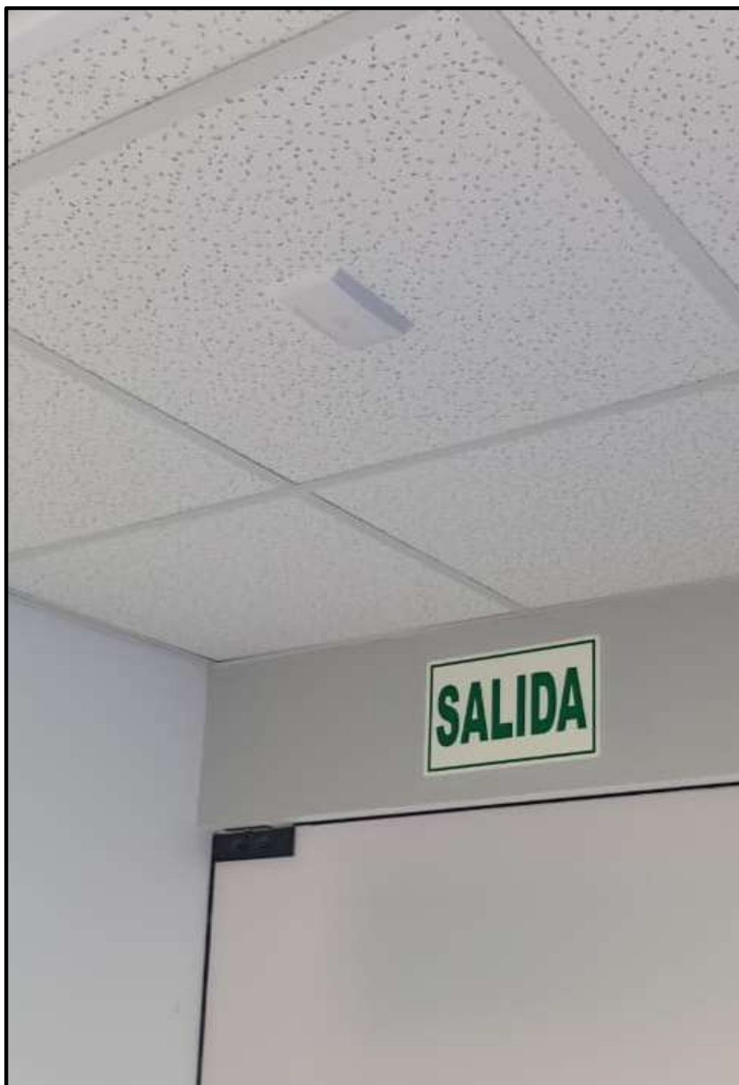
Figura 52 Discriminador de audio apuntando a puerta de vidrio. Fuente: Elaboración propia a partir de registro fotográfico tomado por Ángel Guerrero (2025).
