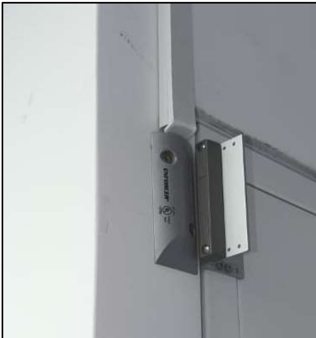
Figura 57 Contacto magnético pesado. Fuente: Elaboración propia a partir de registro fotográfico tomado por Ángel Guerrero (2025).
