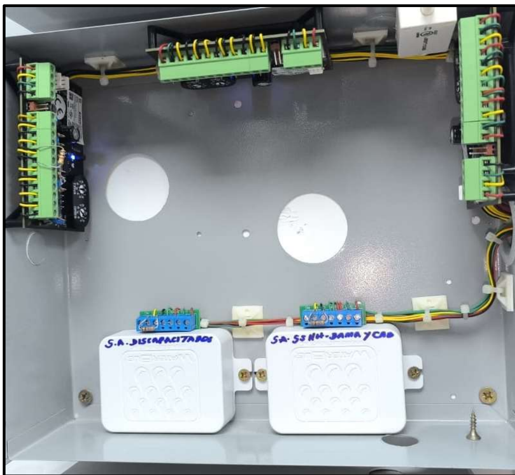
Figura 65 Tarjetas expansoras y procesadores de sensor de aniego. Fuente: Elaboración propia a partir de registro fotográfico tomado por Ángel Guerrero (2025).
