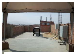
Implementación de los paneles solares
