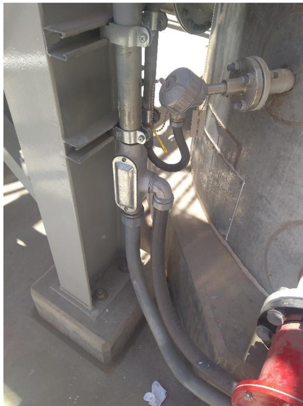
Sensor de temperatura 1624-TE-0070. Fuente: Elaboración propia
