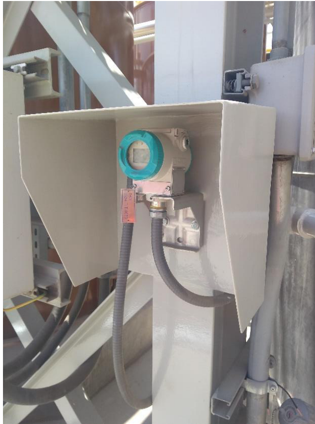
Transmisor indicador de temperatura 1624-TIT -0070. Fuente: Elaboración propia
