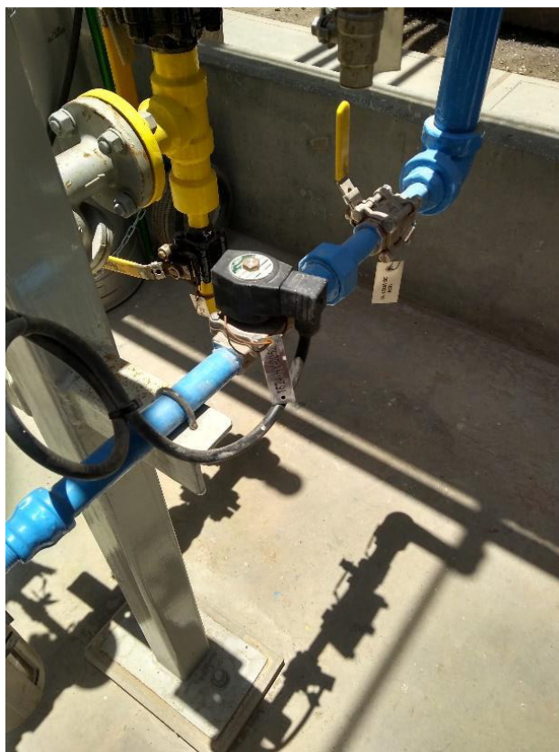
Válvula solenoide 1624-HY-0052. Fuente: Elaboración propia
