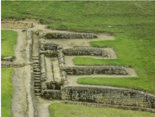
Figura 24: Sistema de acueductos en Ingapirca
