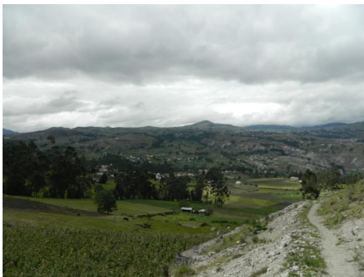
Figura 57: Vista panorámica del lado Sur de la estructura.
