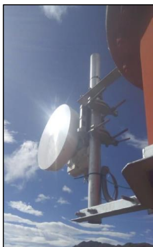
Figura 29 Instalación de la antena y radio en el Site. Fuente: Elaboración propia.
