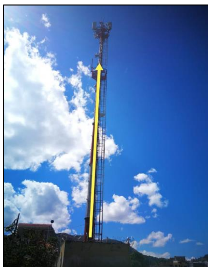
Figura 15 Proyección del cableado y soporte monopolo en el Site. Fuente: Elaboración propia.
