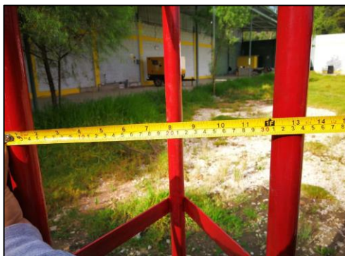
Figura 20 Torre auto soportada en el local del Cliente. Fuente: Elaboración propia.
