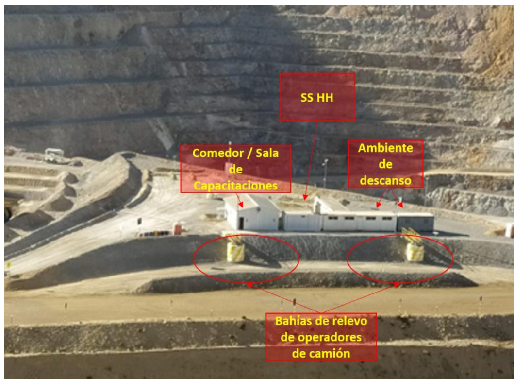
Figura 23. Avance de Infraestructura de Cambio de Guardia en Caliente, mina Pucamarca
