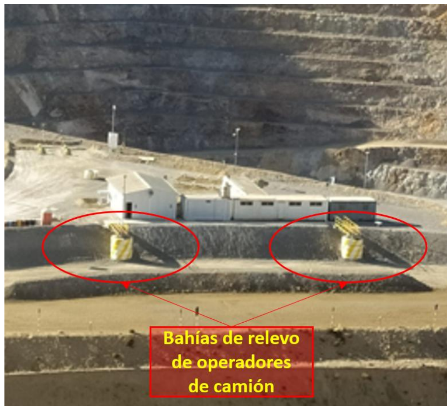
Figura 22. Avance de Infraestructura de Cambio de Guardia en Caliente, mina Pucamarca
