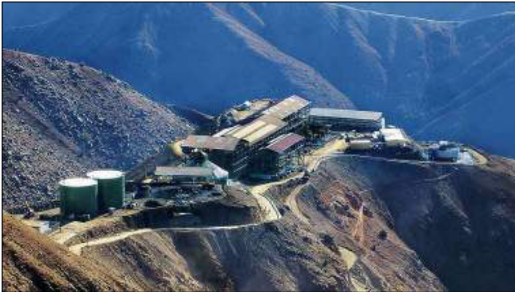
Foto 1.- Vista Panorámica de La unidad Minera Cerro Lindo.
