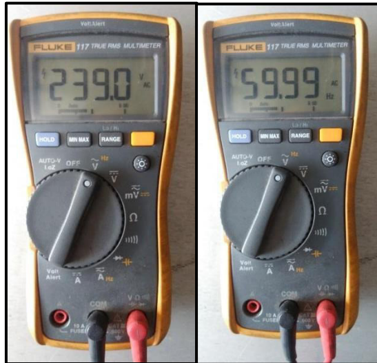
Figura 9. Medida de voltaje de salida y frecuencia de generador eléctrico. Fuente: Elaboración propia.
