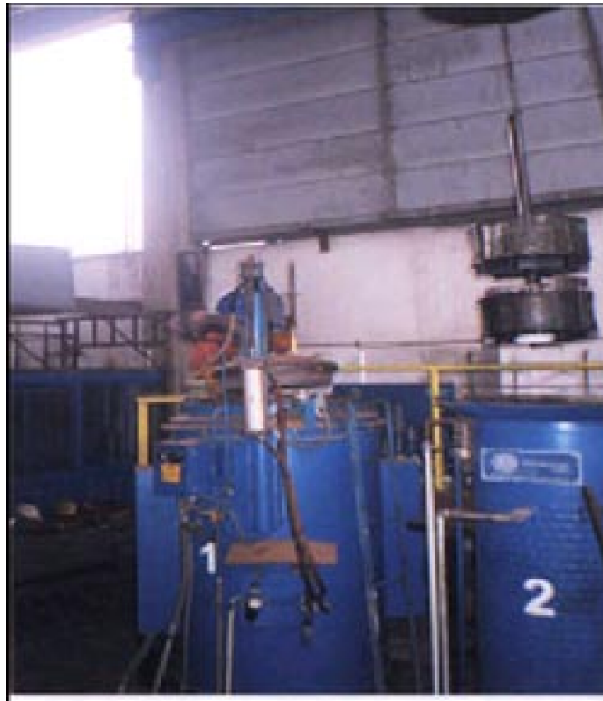
FIG. 4.5. Material muy próximo al ingreso del horno 1
