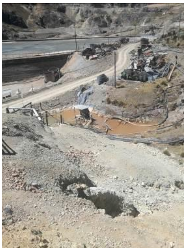
Foto N°6: Evidencia de falta de mantenimiento de la poza de filtraciones y orden y limpieza a sus alrededores.
