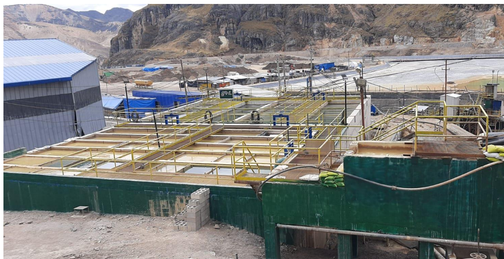
Foto 6: Detalle de la Planta terminada
