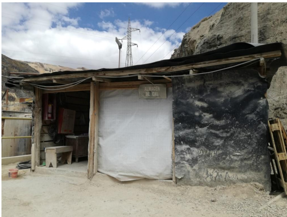
Foto N°11: Almacén de reactivos
