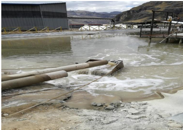
Foto N°1: Planta convencional – Pozas de neutralización
