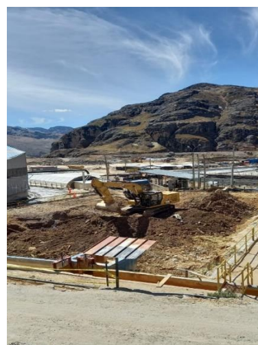
Foto 5: Detalle de la preparación de la Planta
