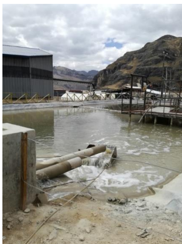
Foto 4: Detalle del ingreso de efluentes
