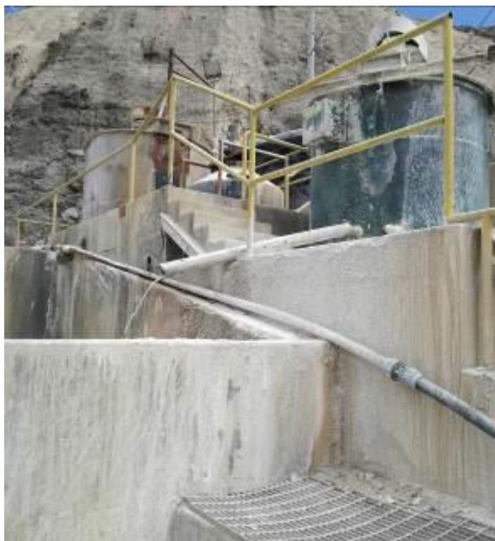
Foto N°2: Dosificación manual de hidróxido de calcio
