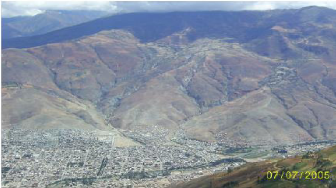
Figura 57. Vista panorámica de la quebrada Tingo Ragra cerca de Rondos, con procesos de deslizamiento y derrumbes en las tres cárcavas principales, muestra antiguos abanicos aluviales, ocupados por viviendas. Fuente: Bilberto Zavala Carrión. INGEMMET. La descripción es nuestra
