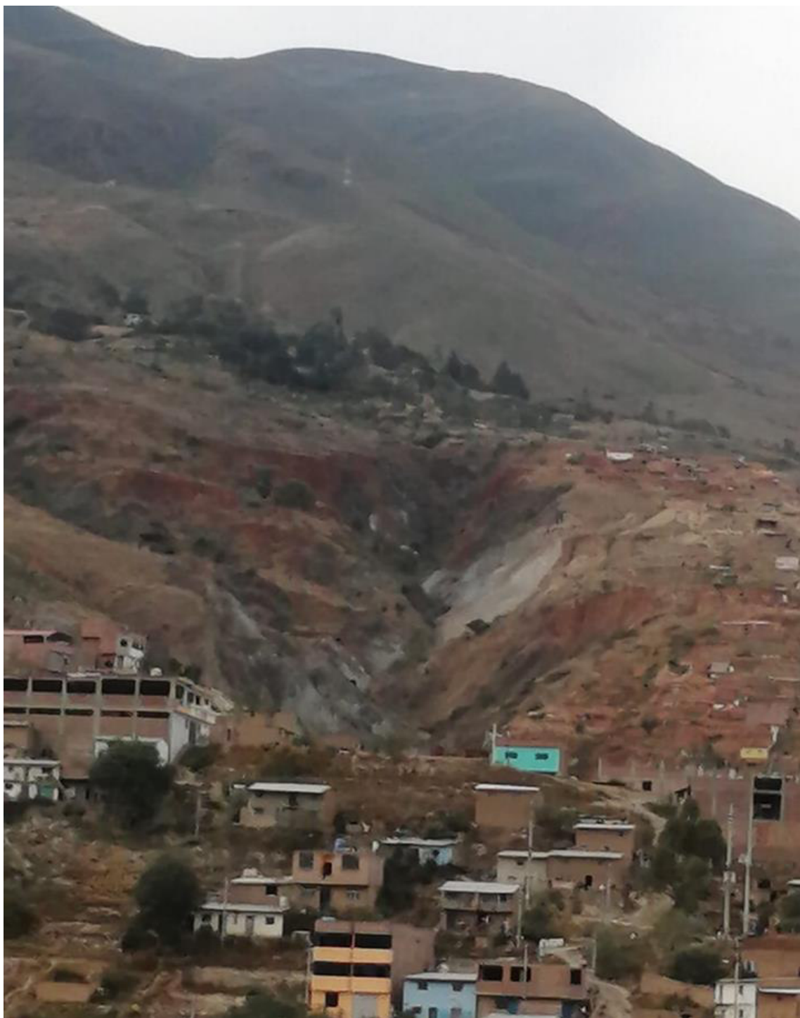
Anexo D La Quebrada Tingo Ragra ocupada por viviendas. Fuente. Archivo propio
