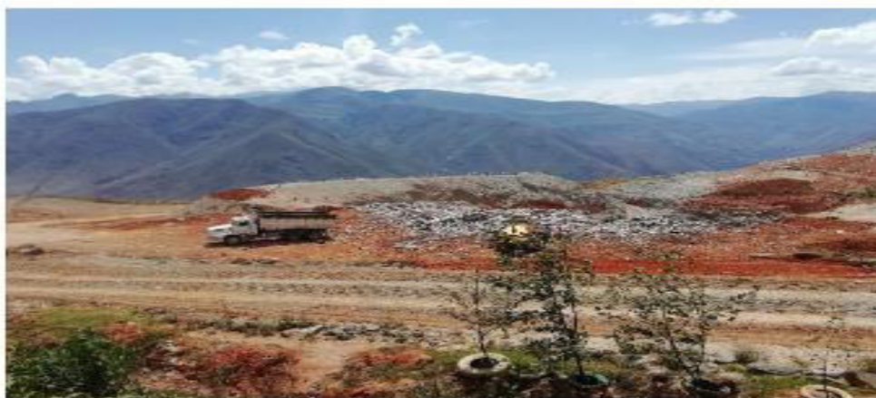
Figura 51. Botadero de basuras de Chilipampa en mantenimiento. Fuente. Municipalidad Provincial de Huánuco, 2019-2029
