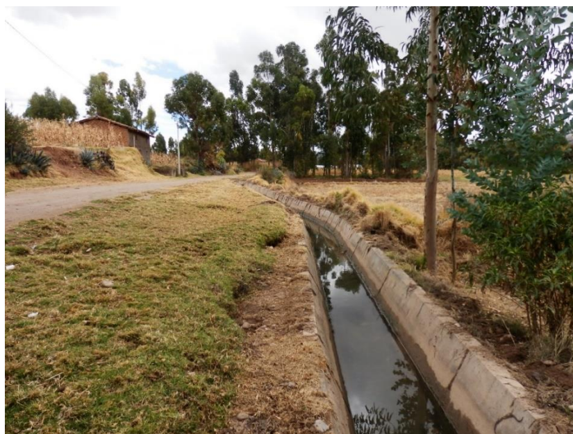
Fotografía 2. Canal que discurre por la margen derecha del río Mantaro, localidad de Sincos.
